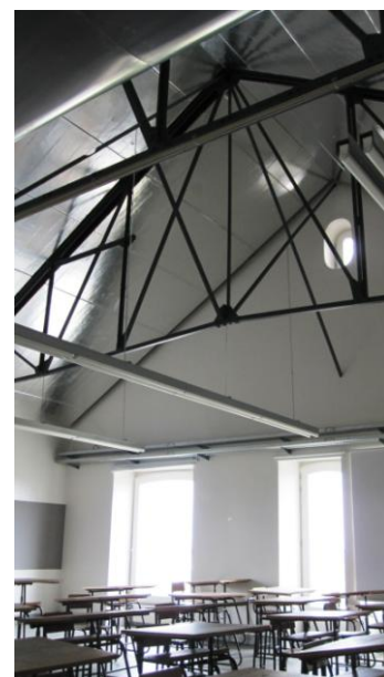
Fig. 8 Interior da pré-existência
