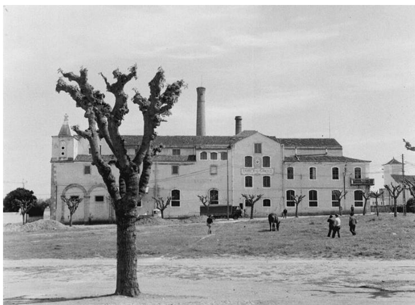
Fig. 26 O Convento de S.Paulo depois da intervenção da fábrica Sofal
