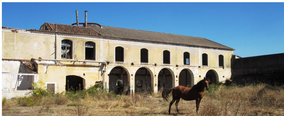
Fig. 36 Edifício a demolir da época da fábrica Sofal
