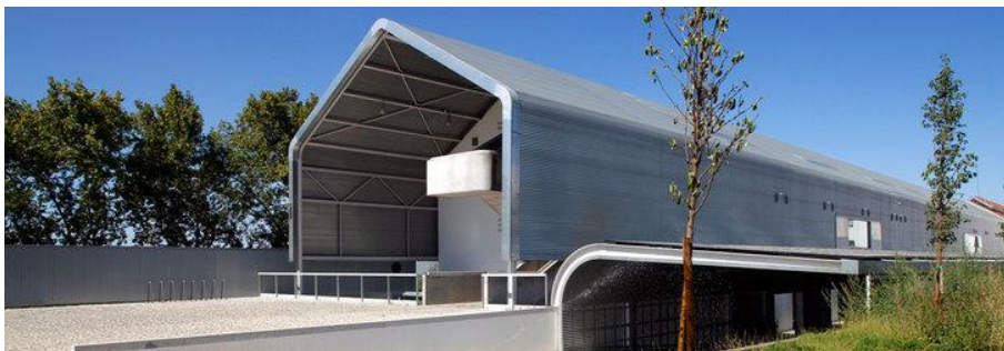
Fig. 7 Relação entre o novo edifício e a pré-existência
