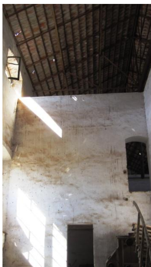
Fig. 37 Interior do edifício do antigo celeiro
