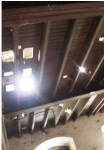
Fig. 33 Iluminação natural a atravessar o pavimento do piso superior do transepto
