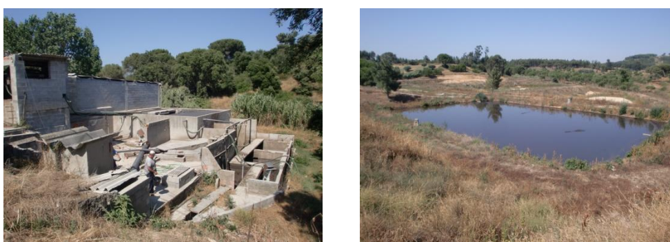
Fig. 5.1 – Tanques de recolha do efluente dos pavilhões e uma das lagoas da pecuária
