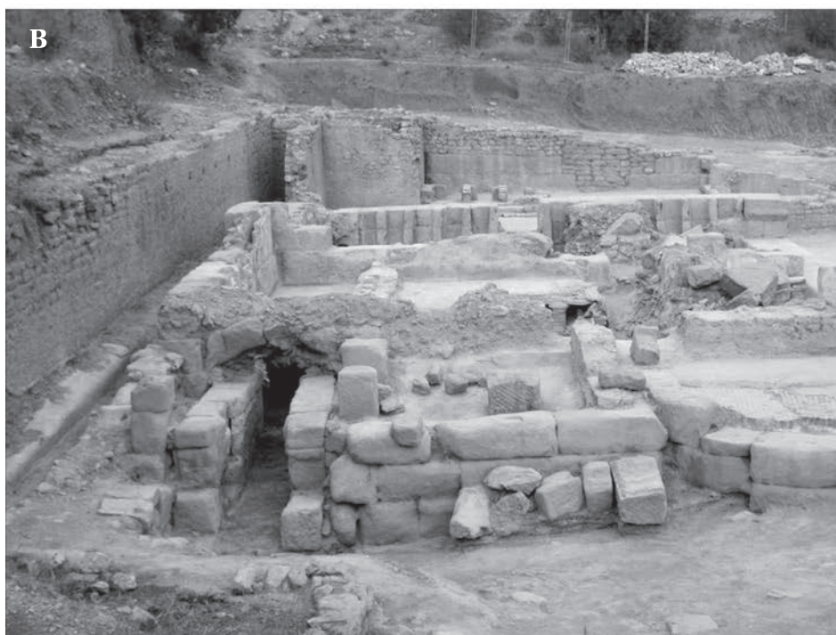
Figura 5. A. Termas de l'Almoina de Valencia, praefurnium de doble cámara conectado con el hipocausto del alveus (Marín y Ribera, 2010: 14). B. Termas I de Labitolosa; en primer término, se encuentra la base del depósito de agua y el praefurnium del caldarium ; a la izquierda se observa el canal que recogería el agua derramada desde la caldera (foto: cortesía de María de los Ángeles Magallón).
