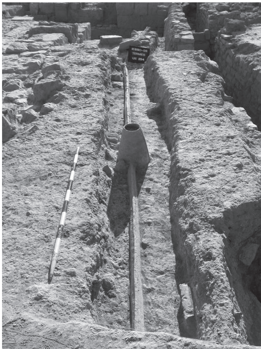
Figura 3. Tramo de tubería con purgador en las termas de Iesso (foto: Equip Iesso).
