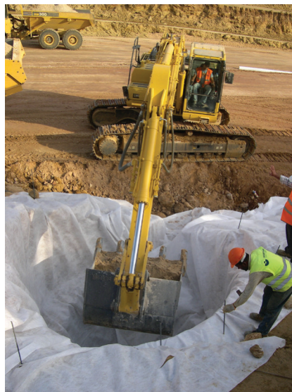
7. Cobertura e proteção do Forno de Vale Casal do Mato.
