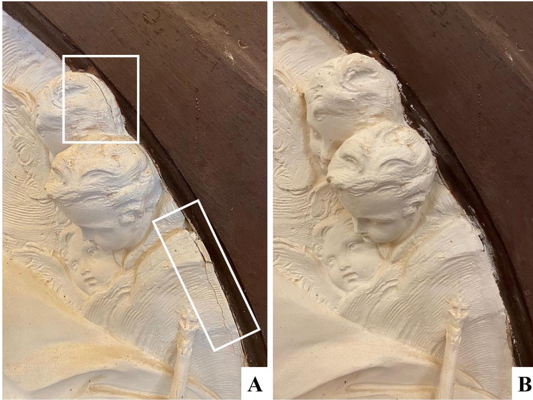
Figura 70 – Anjos junto à moldura. (A) antes do preenchimento – fissuras. (B) depois do preenchimento. ©PNM/Mariana Santos
