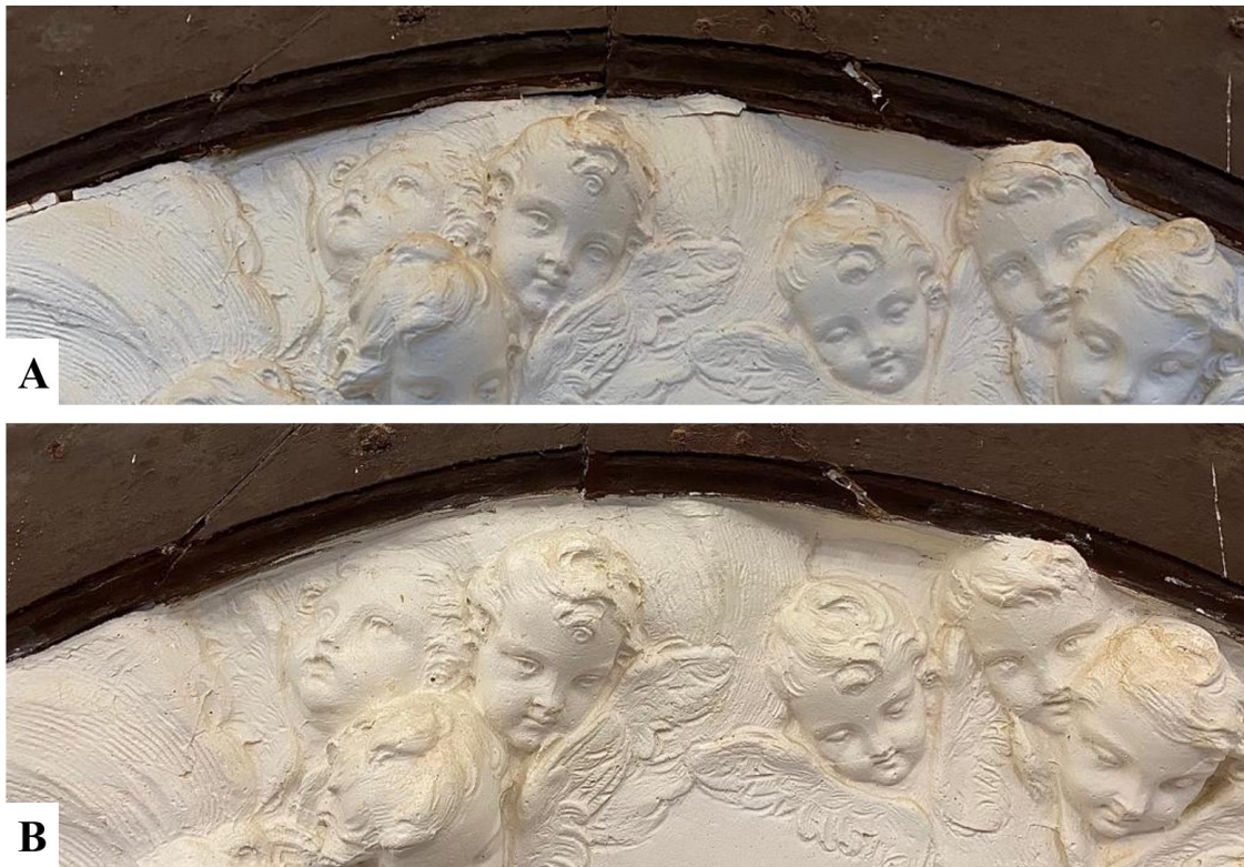
Figura 68 – Anjos junto à moldura de madeira. (A) antes do preenchimento – fenda. (B) depois do preenchimento. ©PNM/Mariana Santos
