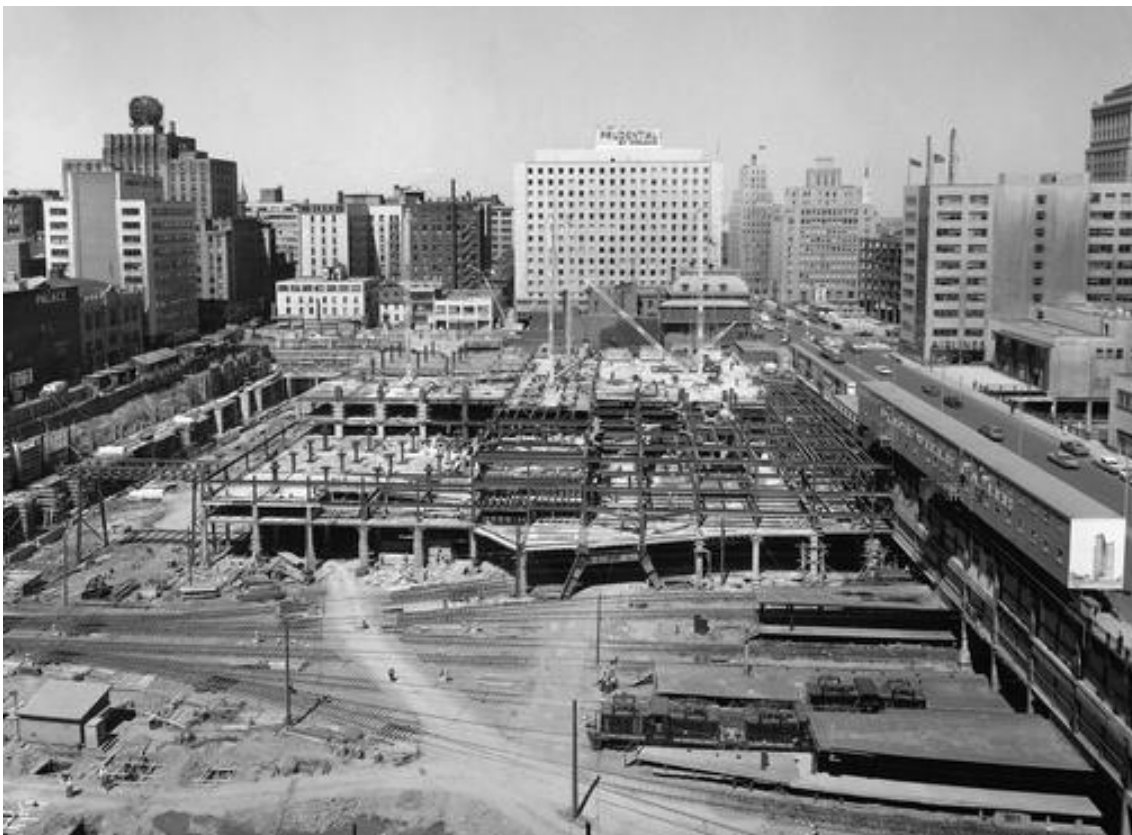
Figura 27 Place-Ville-Marie, construction site
