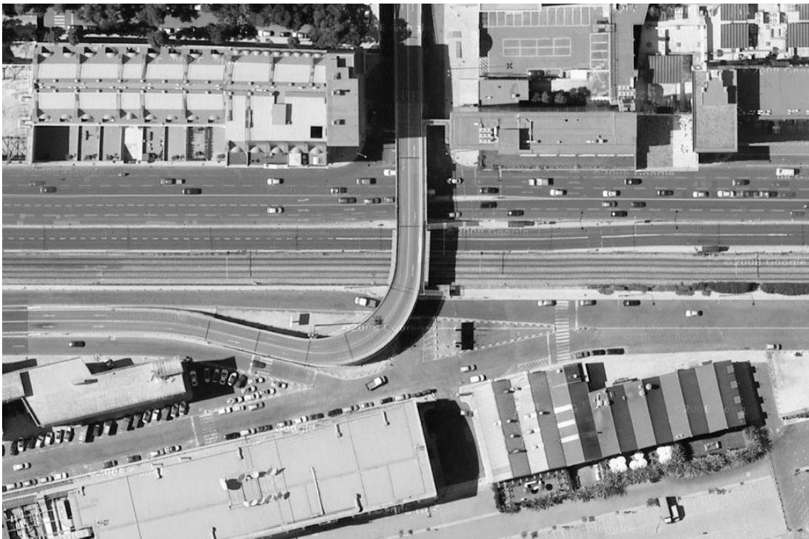
Figura 16 Viaduto em Alcântara
