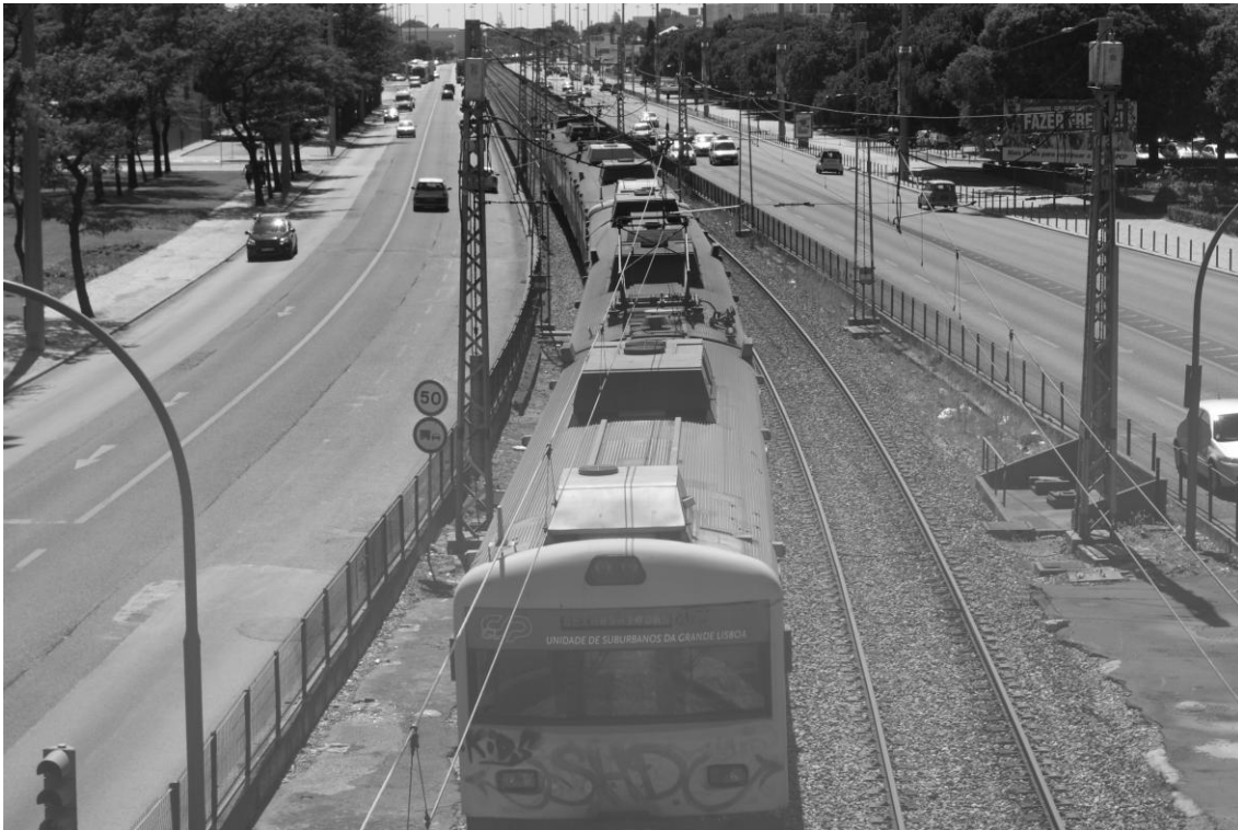
Figura 1 Linha ferroviária suburbana Belém-Cascais, Lisboa
