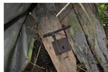
Imagem 69 | Ferrolho para fecho da porta (edifício2)
