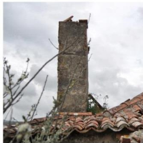
Chaminé rematada por telhas edifício 14
