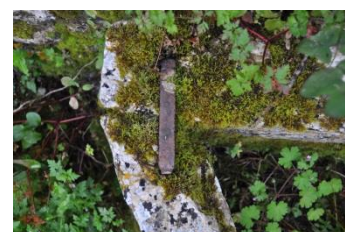
Imagem 85 | Junta metálica 2 (edifício 10)
