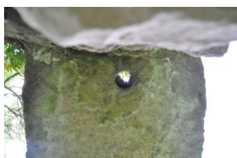
Imagem 68 | Orifício no lintel para porta pivotante (edifício 10)
