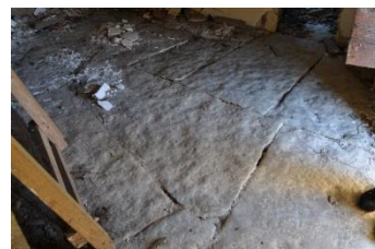
Imagem 70 | Pavimento em pedra (casa de fora, edifício 14)
