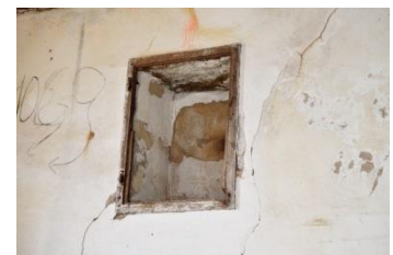
Imagem 31 | Buraca, quarto (edifício 14)
