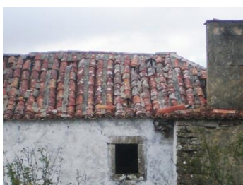
Imagem 73 | Telhado meio-mouriscado (edifício 14)
