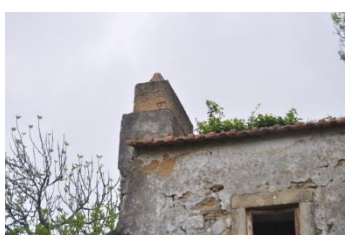
Imagem 29 | Chaminé encimada por prisma triangular aberto superiormente (edifício 1)
