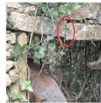
Fracturação da pedra de cantaria
