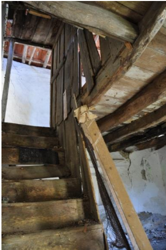
Imagem 86 | Caixa de escadas (edifício 1)
