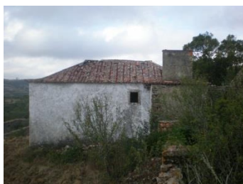
Imagem 43 | Vão do quarto voltado a Norte (edifício 14)
