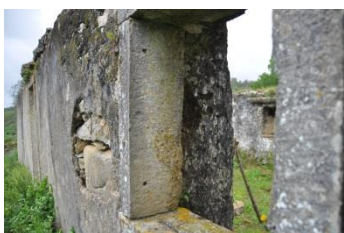
Imagem 64 | Perforação na ombreira para introdução de buchas de madeira (edifício 16)
