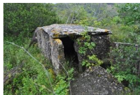
Imagem 47 | Corte (junto ao edifício 16)
