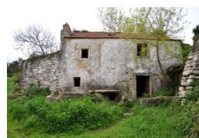
Imagem 26 | Casa de dois pisos corridos (edifício 1)
