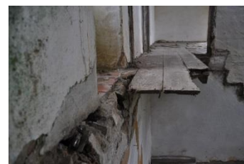
Imagem 71 | Pavimento em soalho de madeira (edifício 14)
