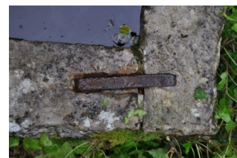
Imagem 84 | Junta metálica (edifício 10)
