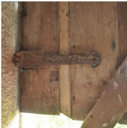
Ferragem de leme e cachimbo Edifício 1
