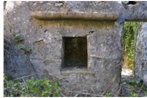
Imagem 38 | Conjunto buraca e cantareira (edifício 16)
