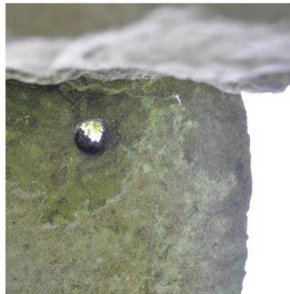
Orifício no lintel para porta pivotante Edifício 10
