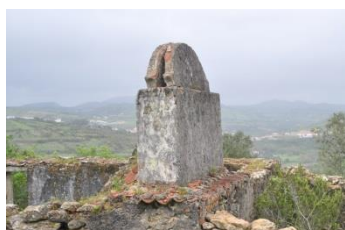
Imagem 28 | Chaminé com fenda de mealheiro (edifício 16)
