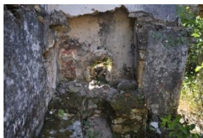
Imagem 79 | Forno (edifício 8, a Sul)
