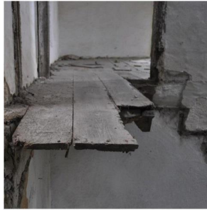
Pavimento em soalho de madeira Edifício 14
