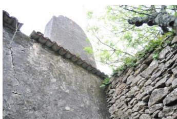
Imagem 27 | Chaminé com fenda de mealheiro (edifício 8)
