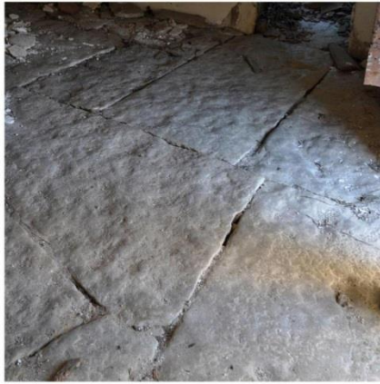
Pavimento em pedra Edifício 1
