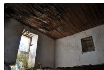
Imagem 72 | Teto em esteira (edifício 14)
