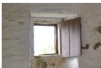
Imagem 65 | Veda-luz (janela de um quarto do edifício 1)
