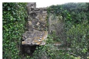
Imagem 49 | Corte (junto ao edifício 18)
