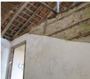
Imagem 58 | Parede em tabique (edifício 14)
