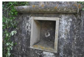
Imagem 36 | Conjunto buraca e cantareira (edifício 11)
