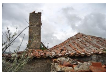
Imagem 30 | Chaminé rematada por telhas (edifício 14)
