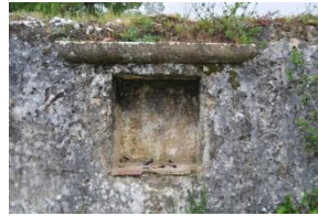
Imagem 39 | Conjunto buraca e cantareira (edifício 18)
