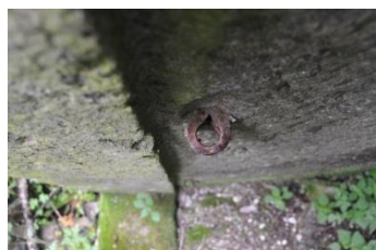
Imagem 67 | Ferragem "cachimbo" chumbado na ombreira (edifício 8)
