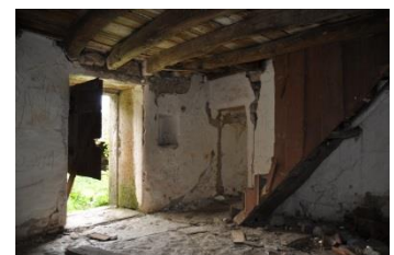
Imagem 33 | Casa de fora (edifício 1)
