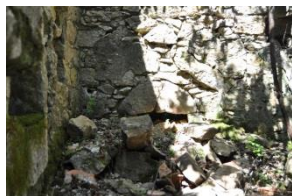
Imagem 78 | Forno (edifício 8, a Norte)
