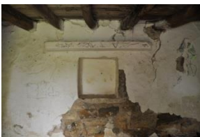
Imagem 34 | Conjunto buraca e cantareira (edifício 1)
