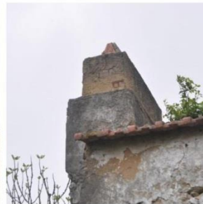
Chaminé encimada por prisma triangular aberto superiormente edifício 1
