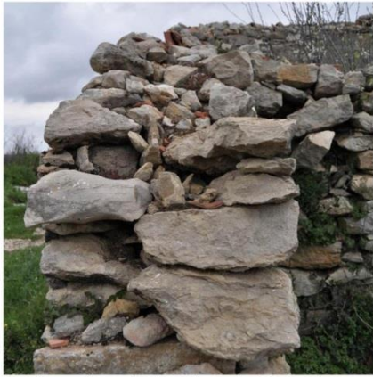
Parede em alvenaria de pedra ordinária com junta seca Edifício 12
