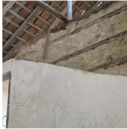
Parede em tabique Edifício 14
