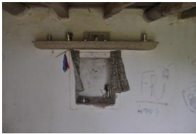
Imagem 37 | Conjunto buraca e cantareira (edifício 14)
