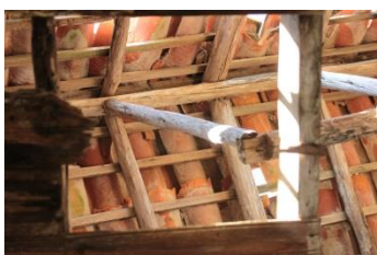
Imagem 75 | Madeiramento da Cobertura (edifício 14)
