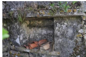
Imagem 35 | Conjunto buraca e cantareira (edifício 10)
