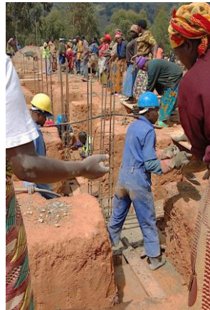
Fig. 26. Fotografia de Iwan Boan, Construção do Hospital . Butaro District Hospital, Ruanda
