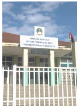
Fig. 56 .. Hospital Pediátrico Pioneiro Zeca
