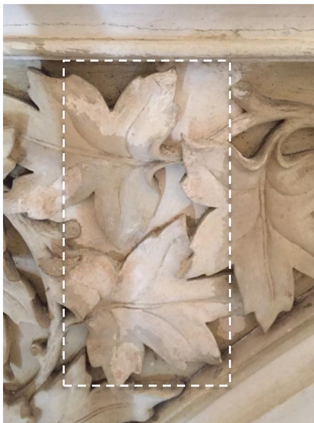
Figura 24 - Pormenor de um ornamento, passado um dia de ter sido realizada a limpeza, no qual se observa a zona limpa; Fonte: Ethan Campian, 2018.
