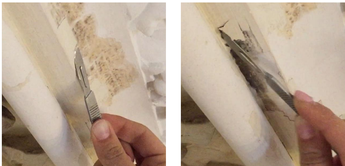
Figura 13 - Em ambas as imagens esta a decorrer a limpeza mecânica, na qual se remove a película cromática em destacamento, com o auxílio de um bisturi; Fonte: Marta Frade, 2018.
