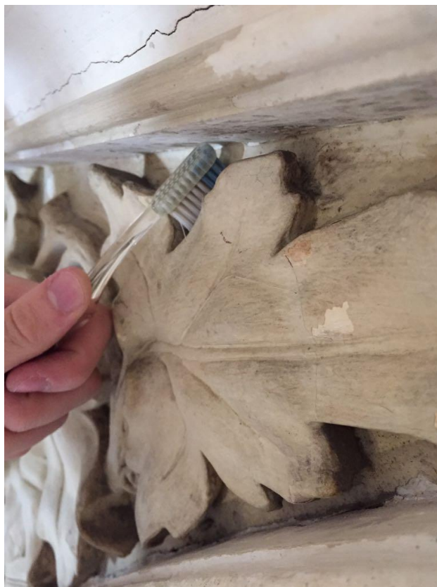
Figura 23 - Limpeza mecânica com escova, para retirar a sujidade acumulada; Fonte: Ethan Campian, 2018.
