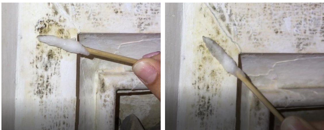
Figura 21 - Antes (esquerda) e depois (direita), de ser realizada a limpeza química com um cotonete e acetona; Fonte: Ethan Campian, 2018.
