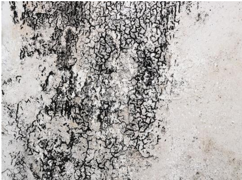
Figura 8 - Mancha negra de bolor numa parede em estuque. Fotografia: Marina Albuquerque, 2019.
