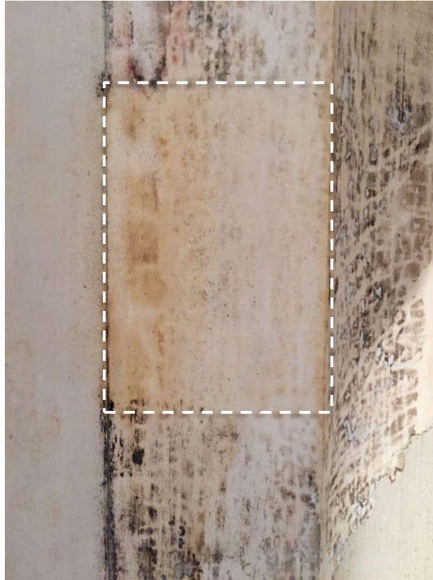
Figura 22 - Secção limpa com acetona, no dia seguinte à realização do mesmo; Fonte: Ethan Campian, 2018.
