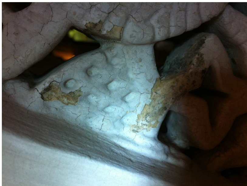
Figura 15 - Pormenor de um ornamento, no qual a película cromática se encontra em total destacamento, e na qual se pode observar sob esta as manchas negras de bolor; Fonte: Joana Guimarães, 2014.
