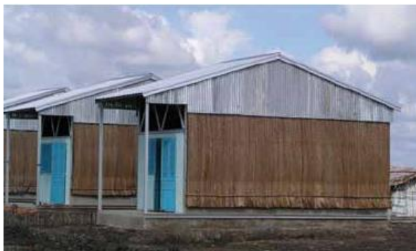
Fig. 30 - Abrigo construído no Vietname em 2004 (IFRC, 2011)
