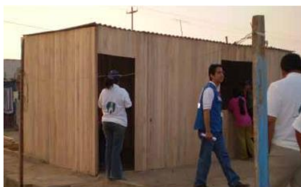
Fig. 22 - Abrigo construído no Peru em 2007 (IFRC, 2011)
