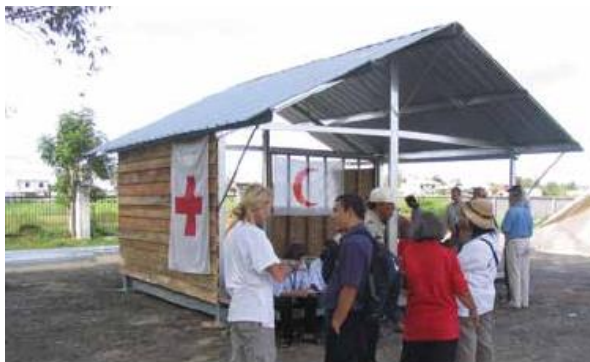
Fig. 28 - Abrigo construído na Indonésia em 2005 (IFRC, 2011)
