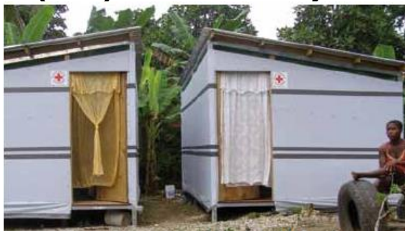
Fig. 26 - Abrigo construído no Haiti em 2010 (IFRC, 2011)
