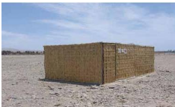
Fig. 24 - Abrigo construído no Peru em 2007 (IFRC, 2011)
