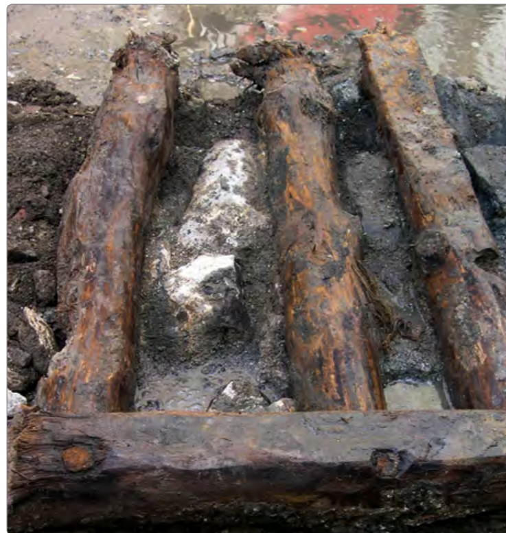
Imagem 9 Detalhe da grelha em madeira com as cavilhas em ferro. (foto de C. Neves)
