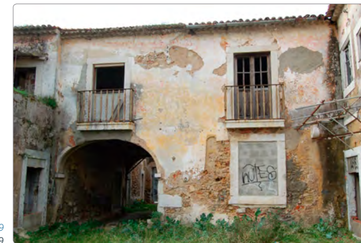
Imagem 9 Pátio Este, fachada Este com o arco da passagem inferior. Novembro 2009
