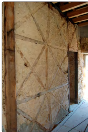
Imagem 11 Estrutura interior em gaiola pombalina. Maio 2012
