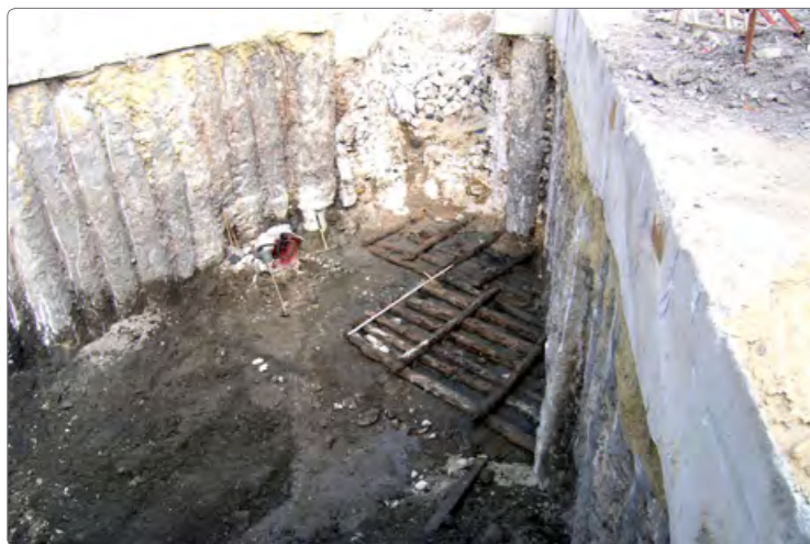
Imagem 8 Base do Paredão e Cais em formato de uma só grelha, confirmando a construção de uma única realidade estrutural, embora com distintas funcionalidades. (foto de C. Neves)
