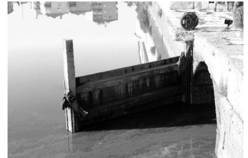
Fig. 006. Porta que permite a entrada e saída da água no moinho - força motriz utilizada para a moagem dos cereais. Moinho de marés de Corroios, 2017. (fotografia do autor).
