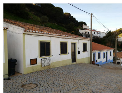
Fig. 44. Habitação vernacular e a sua implantação própria
