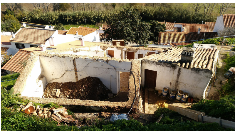
Fig. 117. Casa poligonal vista do topo da encosta
