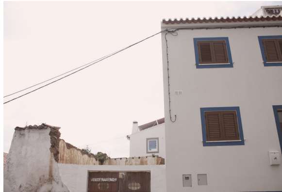
Fig. 40. Perturbação da imagem vernacular devido à utilização de materiais que não respeitam a imagem de conjunto
