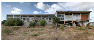
Fig. 133. Antigo centro de saúde, no seu estado atual
