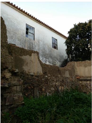
Fig. 49. Parede em taipa com embasamento em pedra
