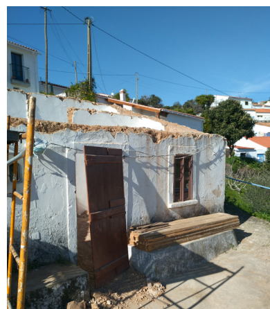
Fig. 118. Casa poligonal, vista da Rua das Parreiras
