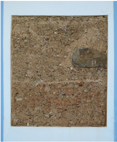
Fig. 48. Pormenor de taipa à vista
