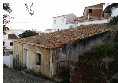
Fig. 46. A cobertura adapta-se ao declive do terreno
