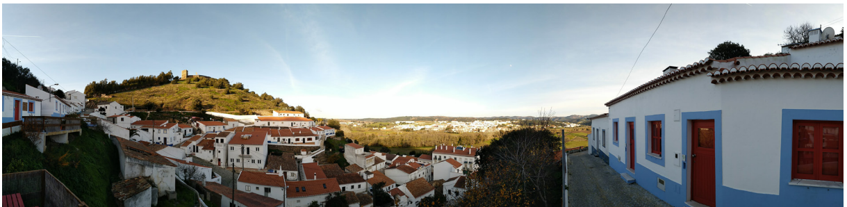
Fig. 66. Panorâmica do Degoladouro
