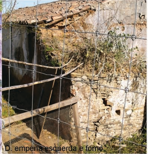
C. interior do poço
