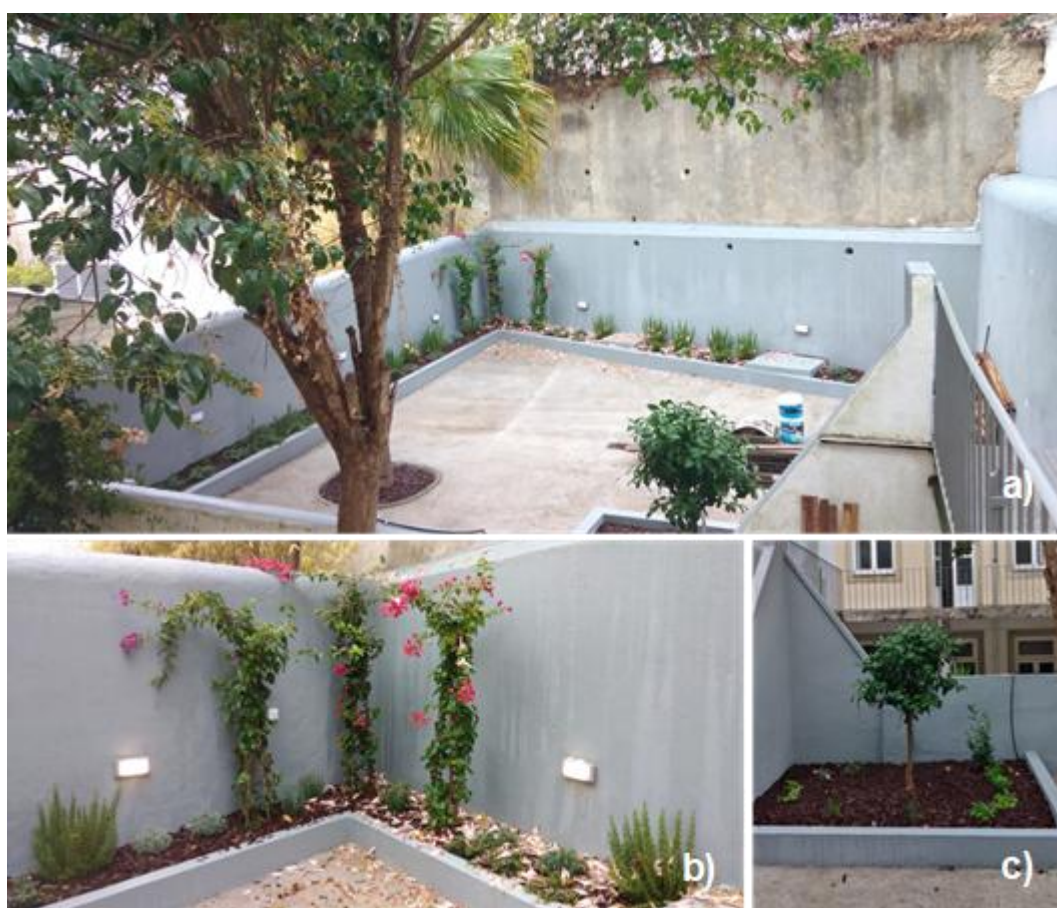
Figura 21. Logradouro em Arroios após intervenção: a) Vista geral; b) Canteiros estreitos; c) Canteiro quadrangular. Fonte: HCG.
