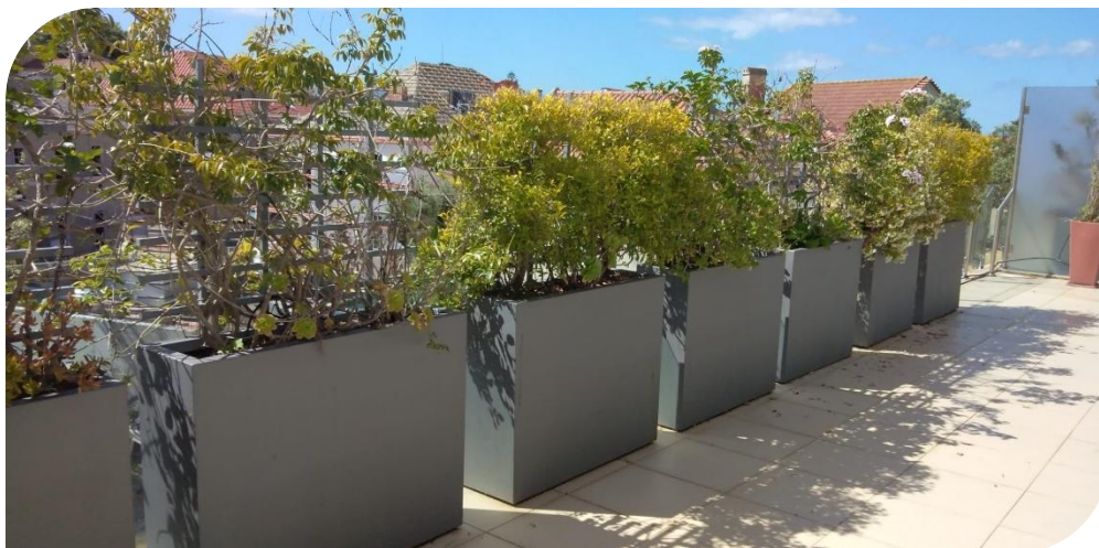
Figura 13. Floreiras metálicas existentes na varanda em Oeiras. Fonte: HCG.
