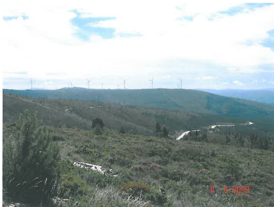
Fotografia 7 – Vista da área situada em Pampilhosa da Serra
