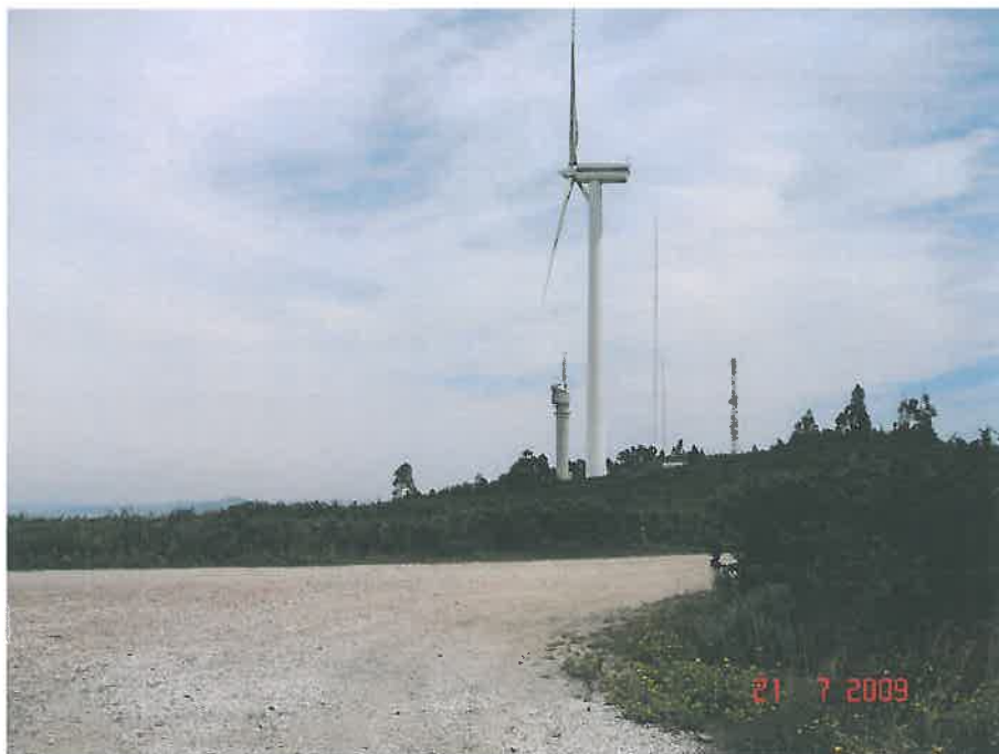
Fotografia 18 – Vista da área situada em Mafra
