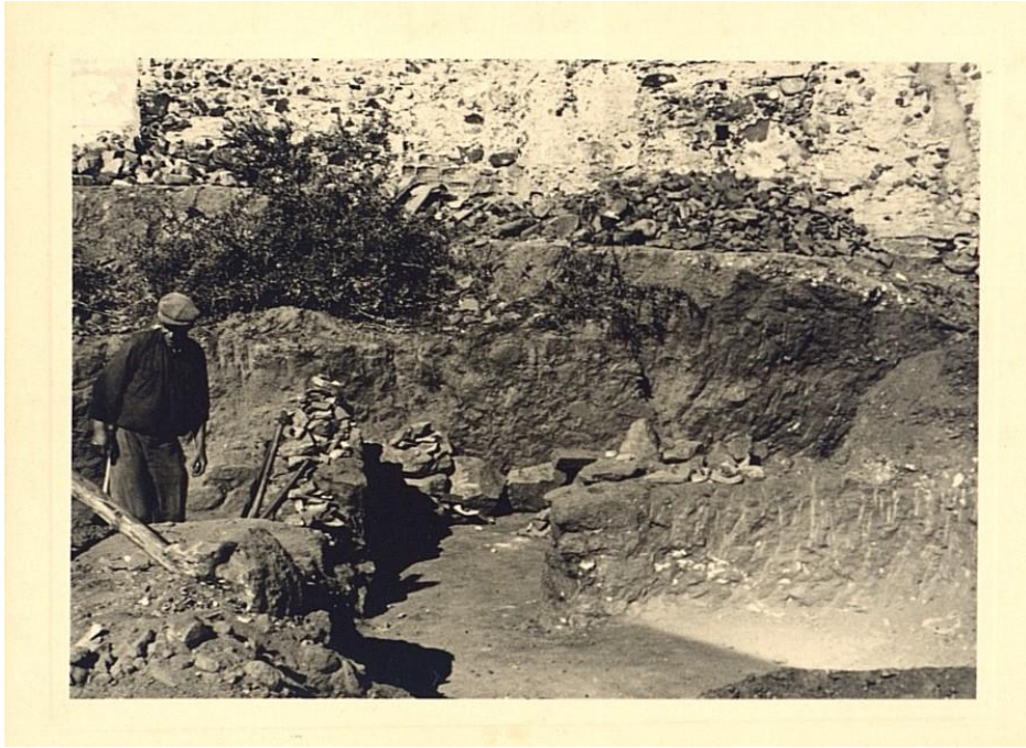
Figura 31- Vestígios da domus romana, com pavimento de terra batida e muros de alvenaria de pedra e cal, onde JMC afirma ter recolhido uma lucerna inteira de pasta clara, uma ânfora funerária, vidros, ânforas e telha. Quintal do Dr. Bento Parreira do Amaral Setembro-outubro de 1961. Figura 21 da página 8 do “Catálogo do Museu Arqueológico Municipal de Sines, Câmara Municipal de Sines.
