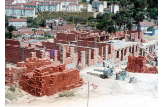
013. Obras SAAL (s.d.)
