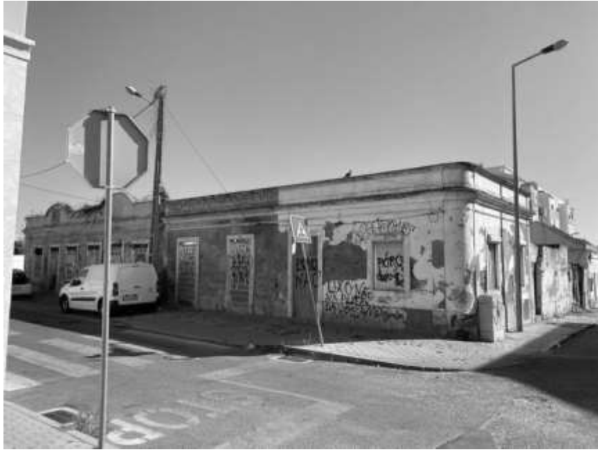
81. Vista do edifício devoluto na área de intervenção - Local 08. Fotografia da autora
