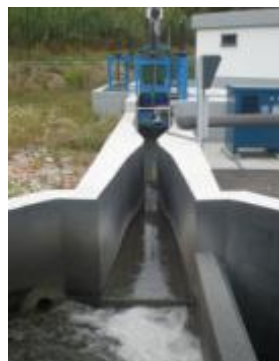
Figura I. 6 - Medidor de caudal (Canal de Parshal).
