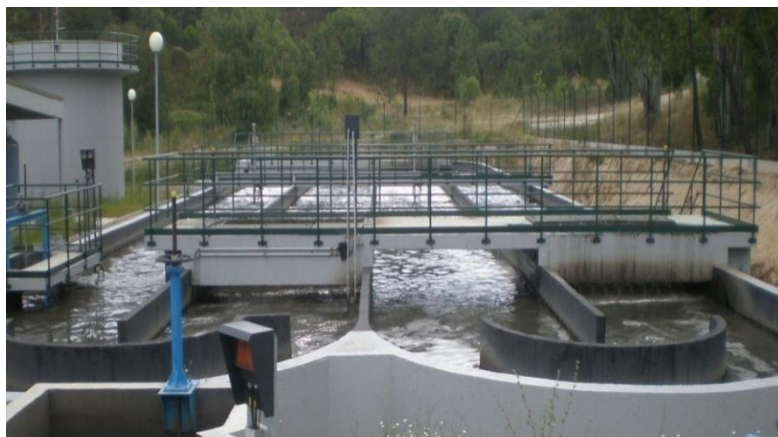
Figura II. 1 - Vala de oxidação.
