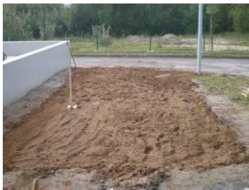
Figura 7.7 - Preparação do terreno.
