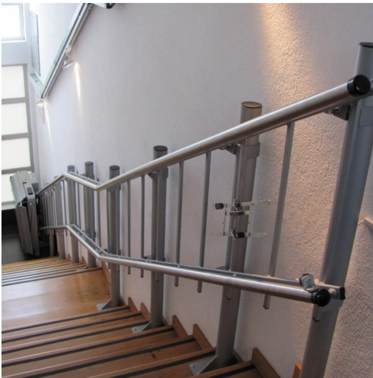
C16 – Pormenor de plataforma elevatória nas escadas.
