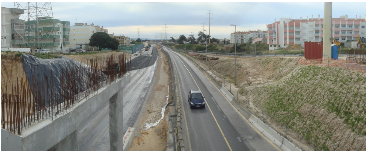
Imagem 22: Obras de prolongamento da CRIPS, Charneca da Caparica. Fotografia por Miguel Rocha.
