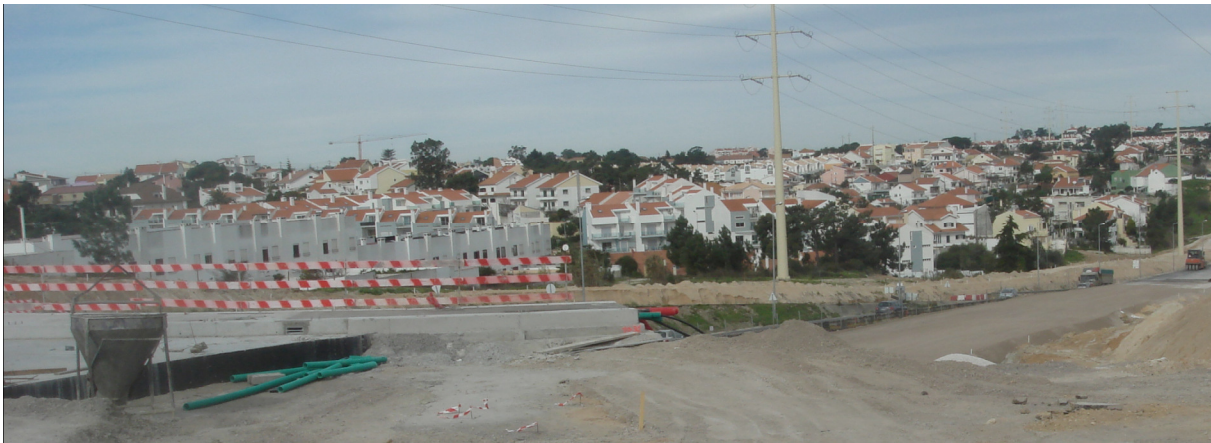
Imagem 21: Obras de prolongamento da CRIPS, Charneca da Caparica. Fotografia por Miguel Rocha.
