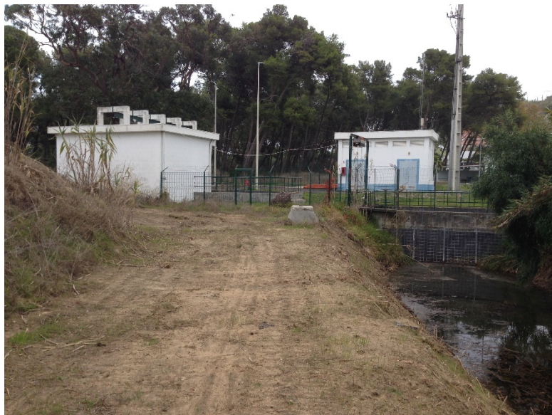
Figura 20 / Estação elevatória e emissário do Torrão
