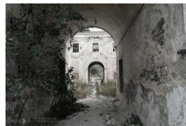
Figura 69. Pátio das Nonas, arco sobre alameda central.
