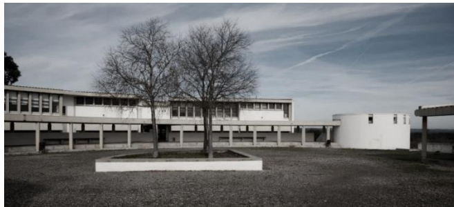
Figura 40. Fotografia Pátio do Grupo de Aulas.
