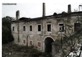
Figura 57. Palácio, fachada Sul.
