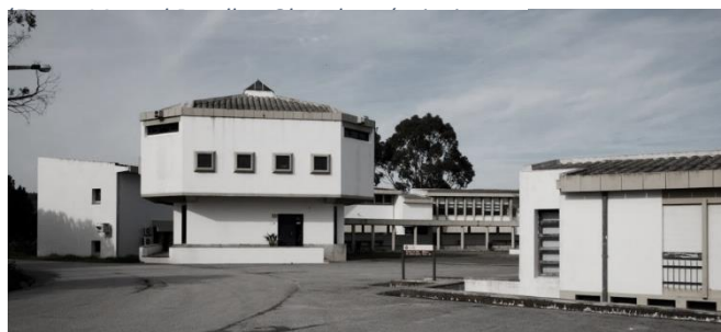
Figura 39. Fotografia Pátio do Grupo de Aulas.
