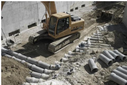
Figura 28. Mapa de sistema de tubagens entre edifício e poço de admissão de ar. Figura 27. Poço de admissão de ar integrado na envolvente ajardinada. Figura 30. Tubagem no solo.
