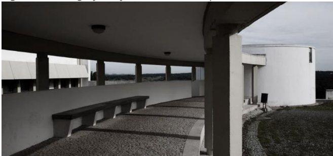
Figura 41. Fotografia passagem coberta no pátio.
