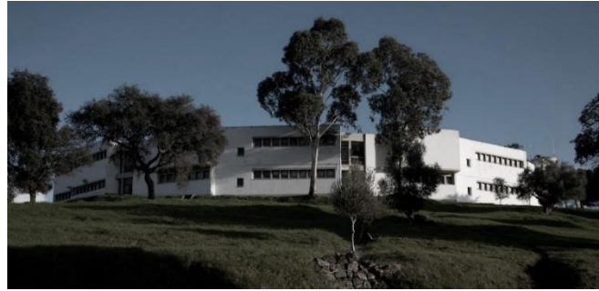
Figura 42. Fotografia Alçado Norte do Grupo de Aulas
