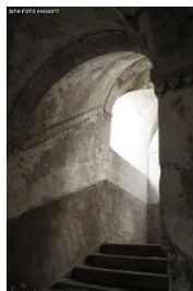
Figura 70. Interior da capela.
