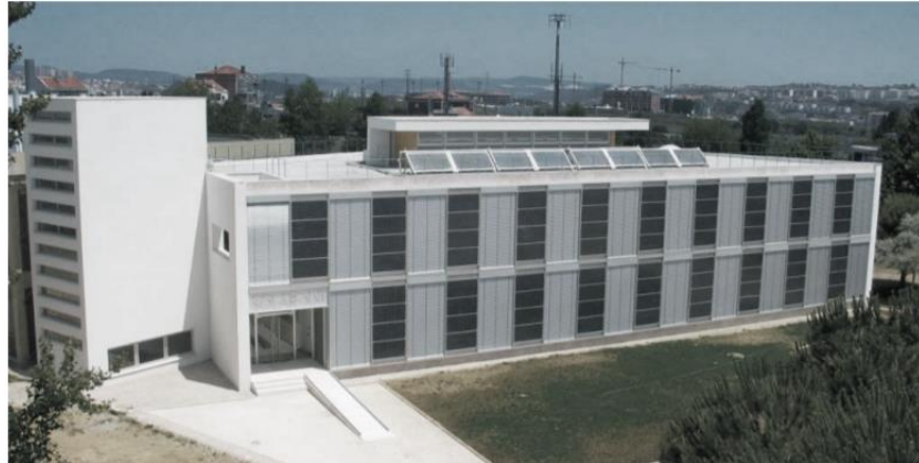
Figura 32. Perspetiva do edifício onde se pode observar os painéis fotovoltaicos na fachada e os coletores solares na cobertura.
