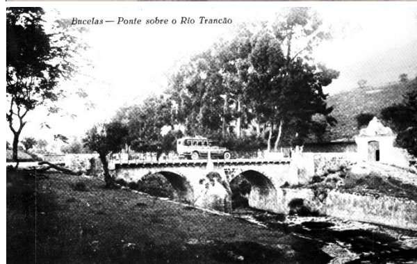
Figura 11. Ponte sobre o rio Trancão, Bucelas, s.d.
