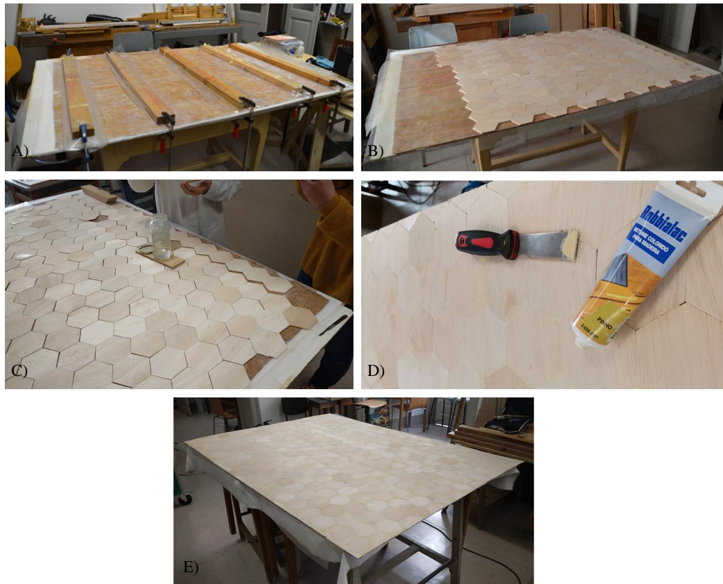
Figura 56 – Construção da camada intermédia mediante o método de parquetagem. A) Após aplicação da folha de TNT. B) Disposição dos hexágonos. C) Colagem dos hexágonos. D) Preenchimento das juntas E) Após aplicação da camada de balsa (©Rafaela Santos, 2022).
