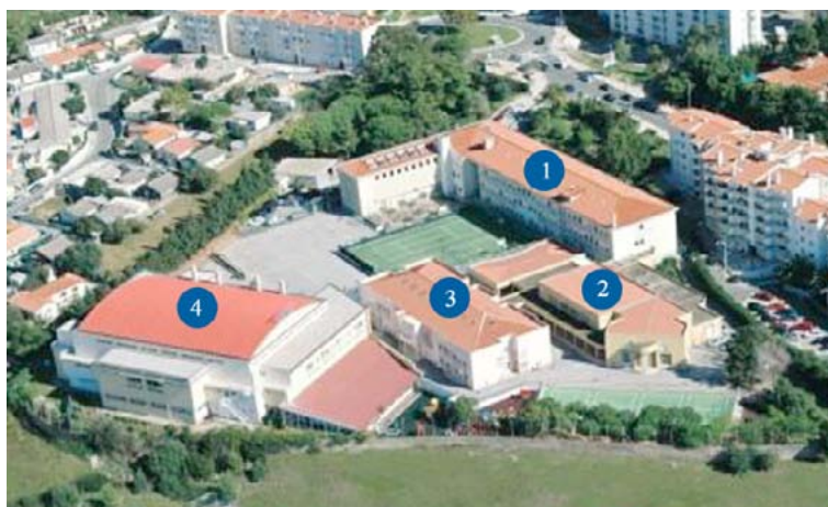
Figura 4. Todos os edifícios que compõe o espaço da escola
