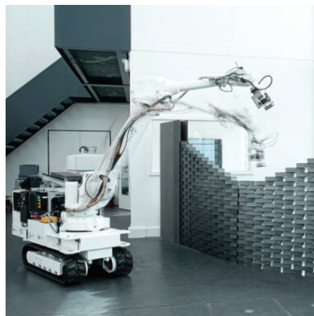
Fabricação in situ com recurso a robot autónomo, Zurique, Suíça (in https://www.engenhariacivil.com/robot-autonomo-construcao )
