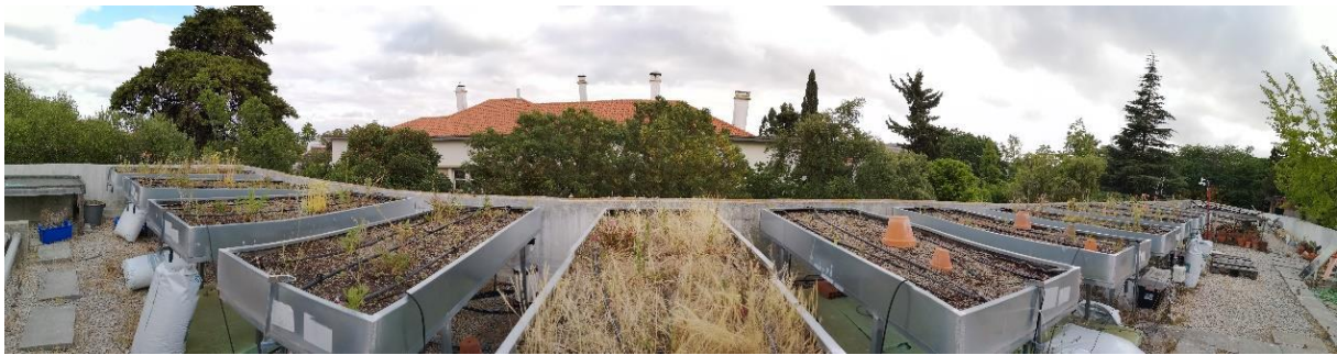
Figura 39 – Imagem panorâmica dos tabuleiros de metal localizados na cobertura do Herbário do ISA, na qual também se pode observar o sistema de rega (Martins, 2018).
