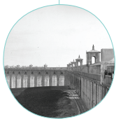
1852 Encerramento do Aqueduto
