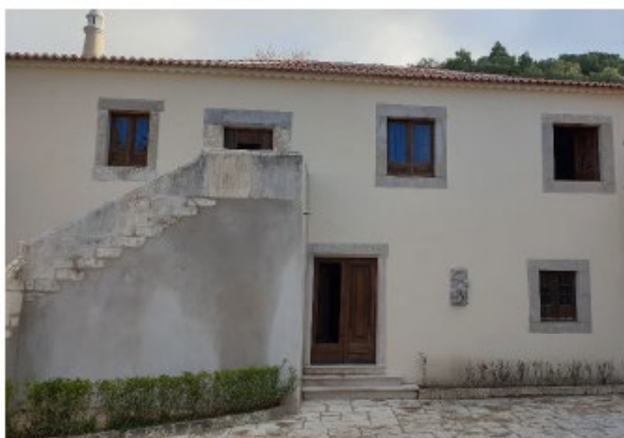
Fig.: 67, 68 e 69 – Antes e depois da intervenção que está a decorrer. Fotografias da autoria de Tatiana Marques e do Autor.
