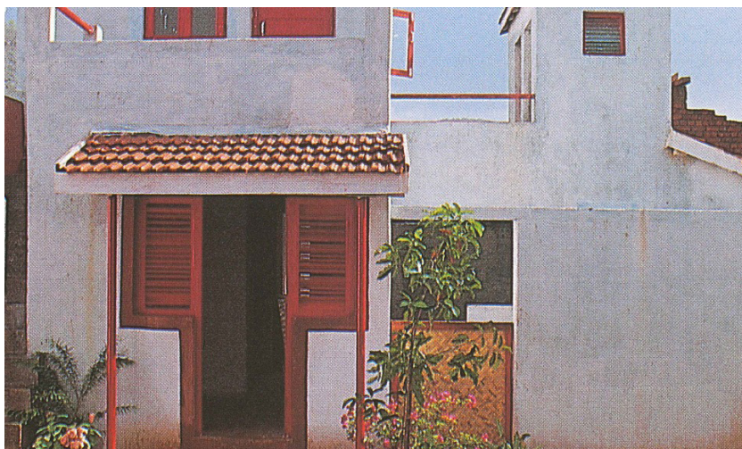
Figura 97. Belapur housing - relação interior exterior
