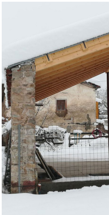
84 | Pajar Ojastro: fotografia do processo de reabilitação do edifício.
