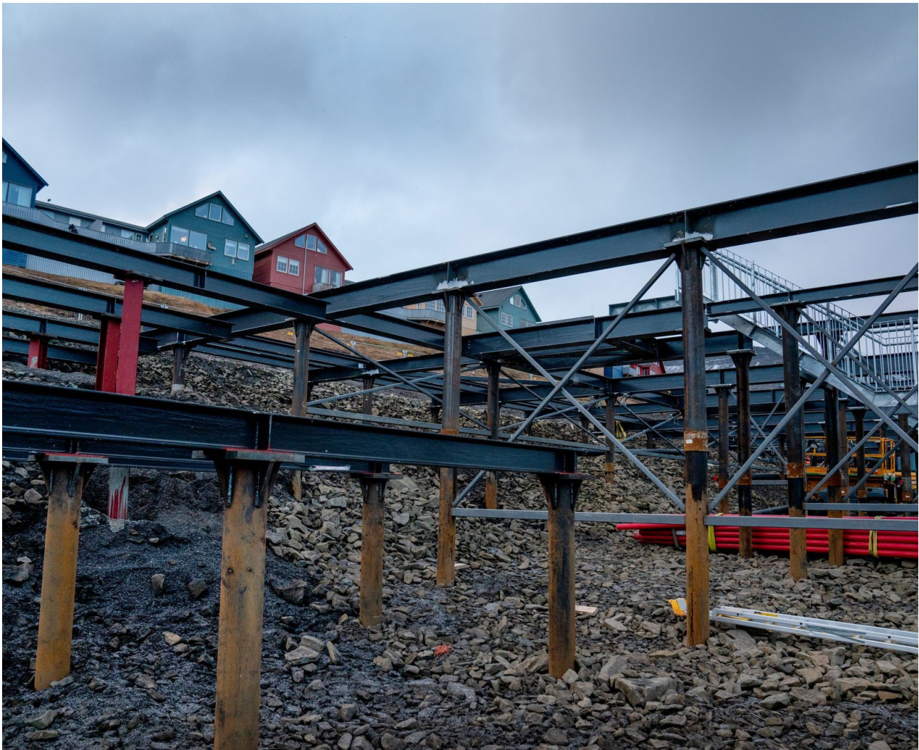
70 | Boliger Longyearbyen: fundações dos blocos de habitação durante a construção.
