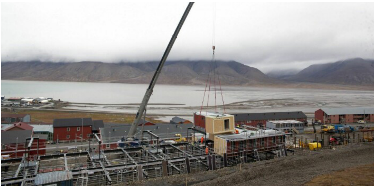
75 | Boliger Longyearbyen: montagem das unidades de habitação sobre a estrutura metálica.
