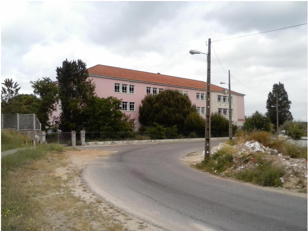
Vista exterior. 2018 Fotografia da autora.
