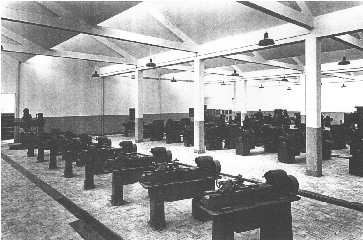
Vista interior da oficina de serralharia. 1956 Fonte: Arquivo Municipal de Lisboa.
