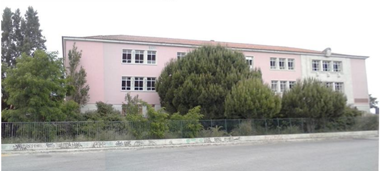
Vista exterior Corpo A. 2018 Fotografia da autora.
