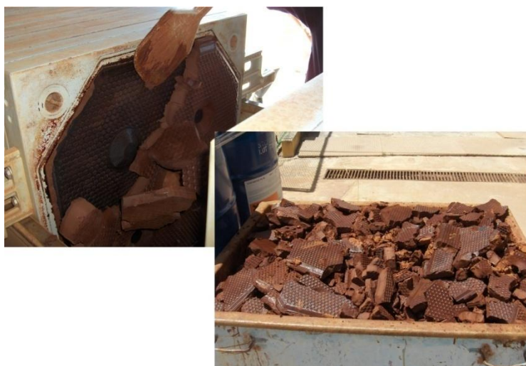
Figura 6.17. Remoção das lamas do filtro de prensas
