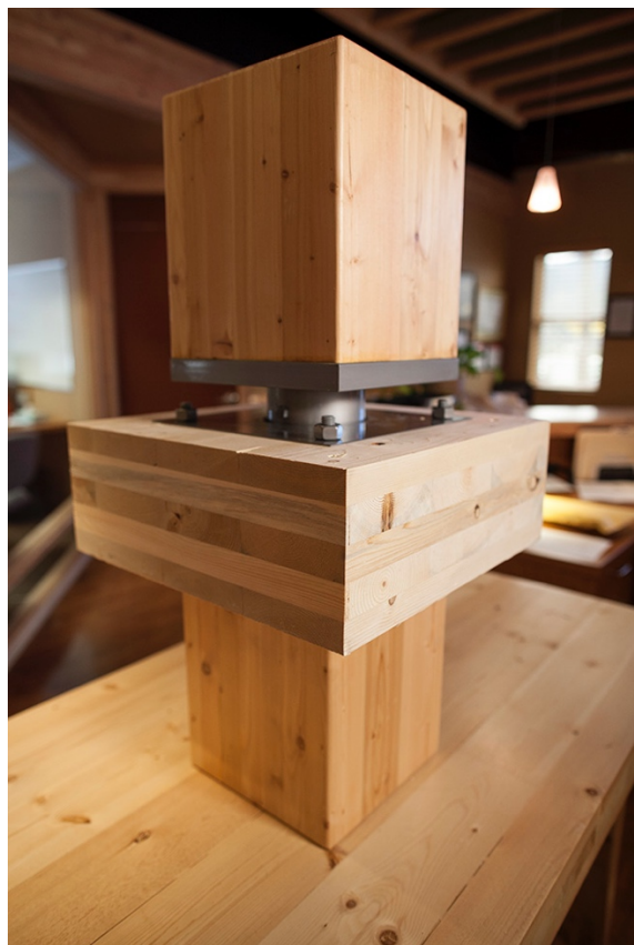
| 71 | Pormenor de Nó CLT com Placa Metálica
