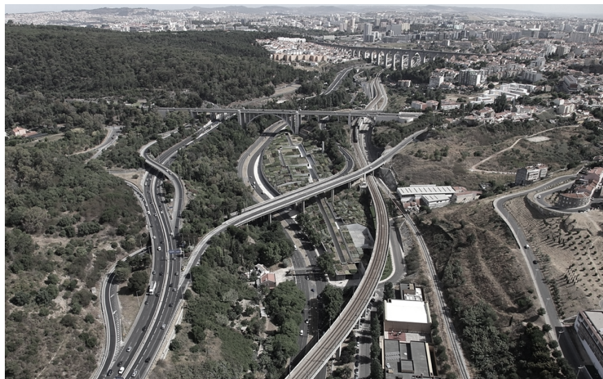
| 15 | Construção do Viaduto Duarte Pacheco sobre a ribeira de Alcântara
