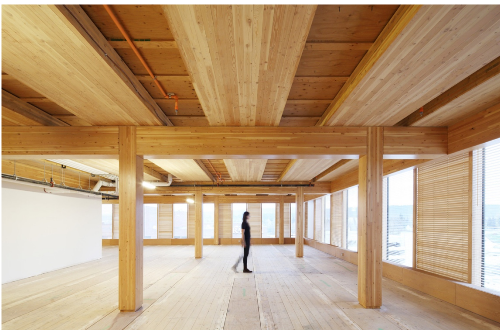
Laje de CLT | 68 |
