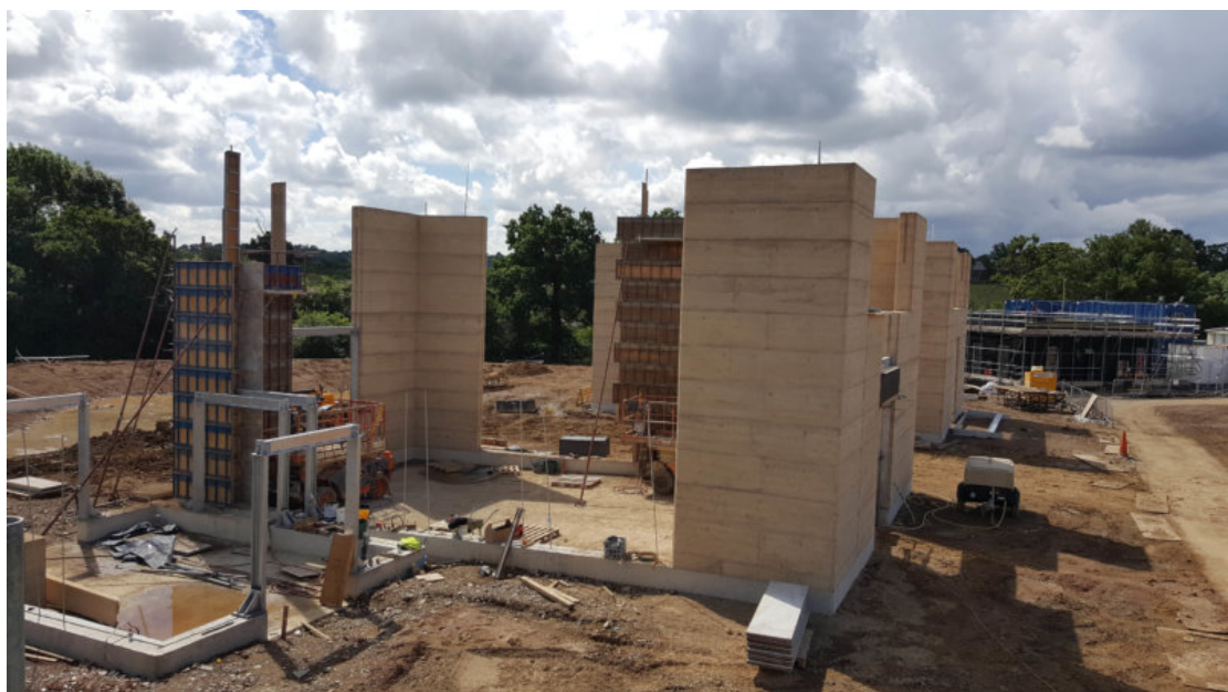
| 67 | Parede de Betão de Terra em Construção
