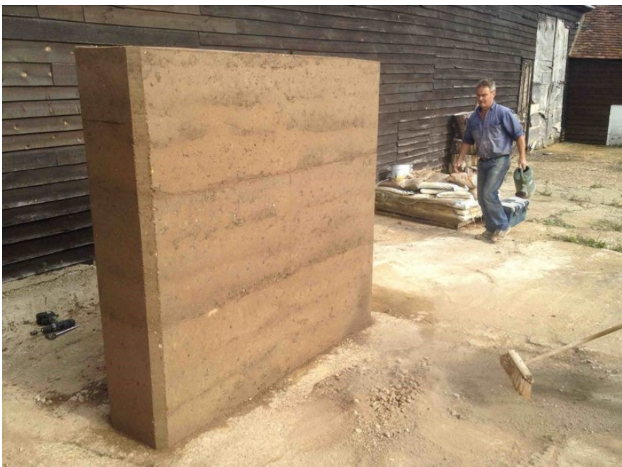
Amostra de Parede de Betão de Terra com Mistura Final | 66 |
