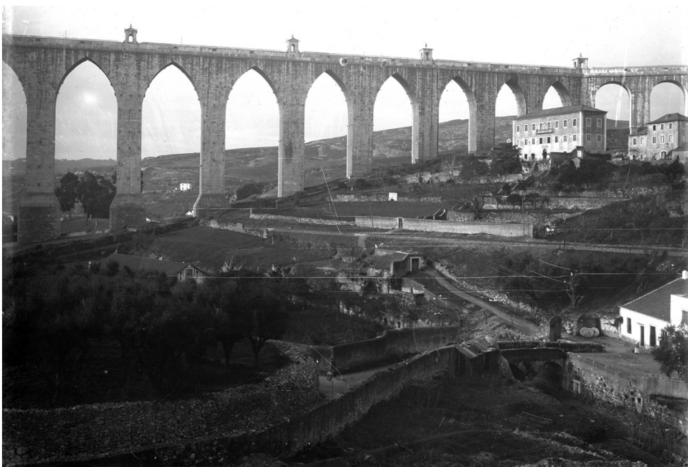
Panorâmica parcial do Aqueduto | 07 |
