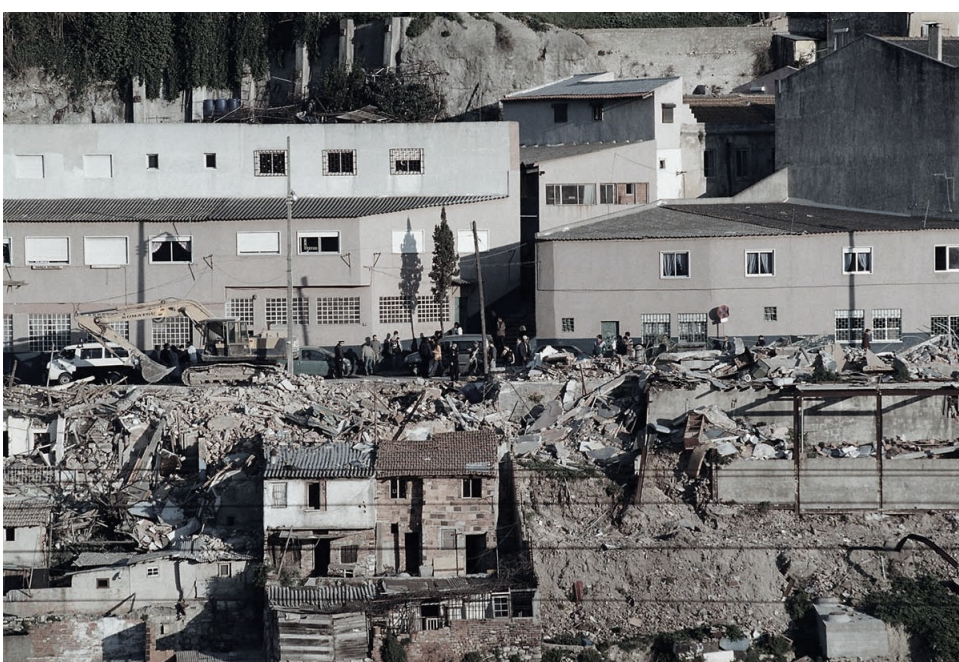
Demolição de Bairro em Alcântara | 03 |
