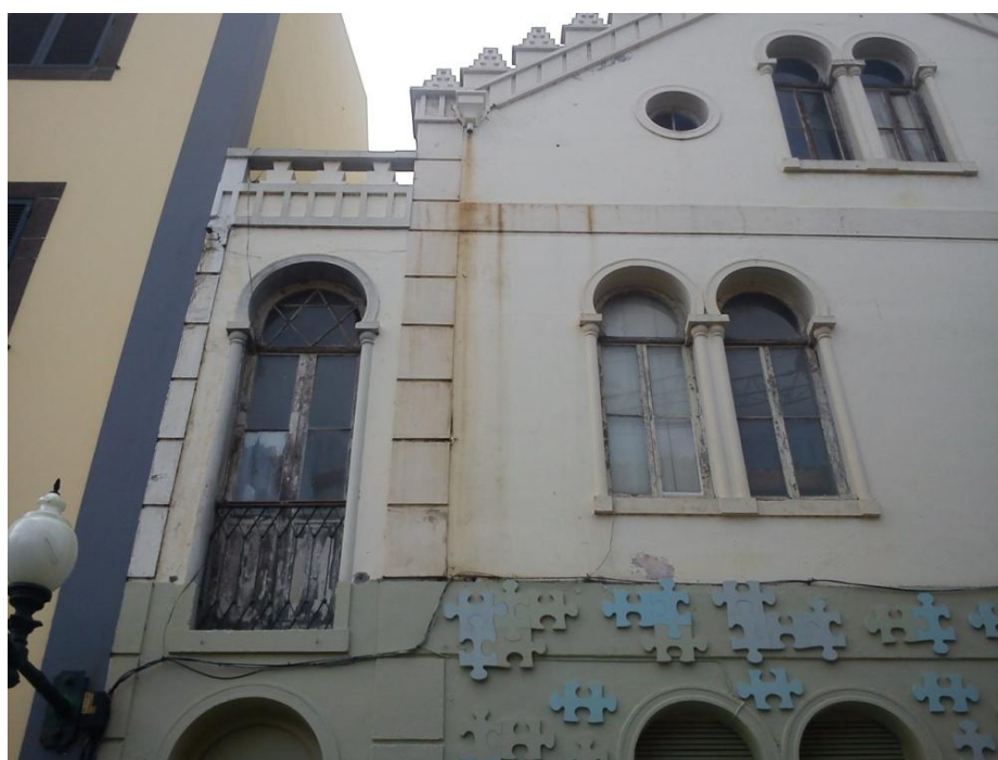
Imagem 22 – Janela do edifício da Rua do Carmo n. 33 – vista exterior
