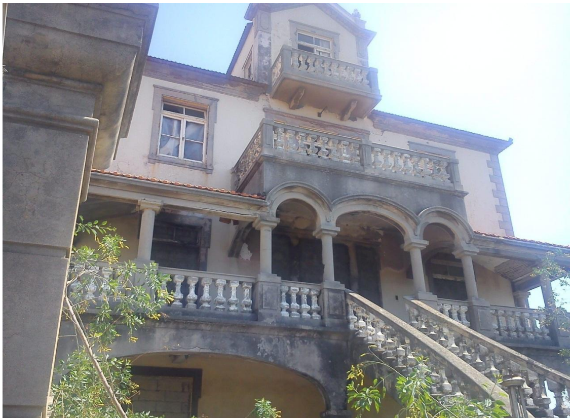
Imagem 27 – Estado atual do edifício na Calçada do Socorro n.2 (2014)
