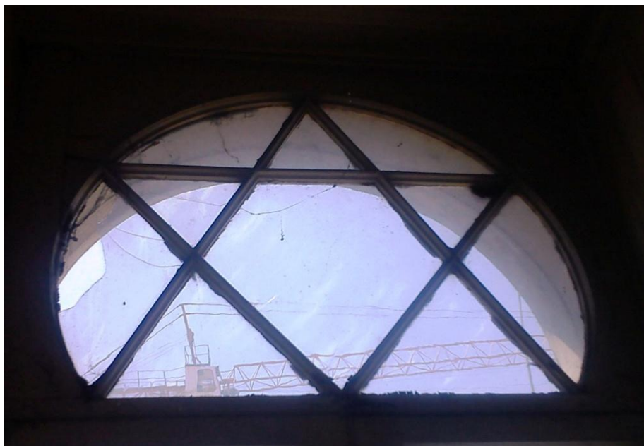
Imagem 23 – Janela do edifício da Rua do Carmo n. 33 – vista do interior
