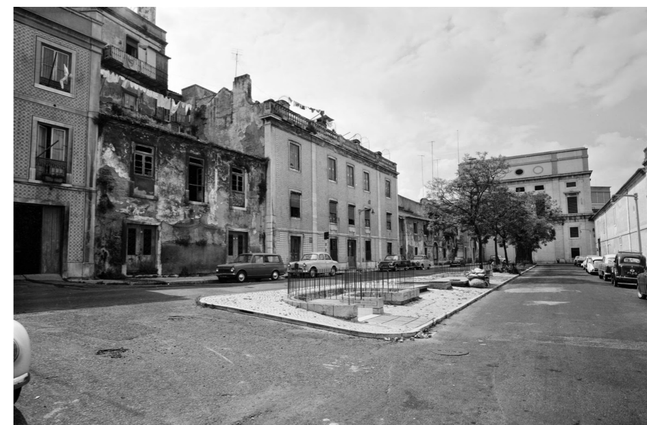
08. "O antigo complexo no pátio do ex-Convento do Beato, onde se instalaram as casas das caldeiras e das máquinas a vapor", Autor Desconhecido Disponível em: https://aps-ruasdelisboacomhstria.blogspot.com/2015/02/rua-do-beato-viii.html
