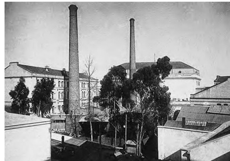
07. "O antigo complexo no pátio do ex-Convento do Beato, onde se instalaram as casas das caldeiras e das máquinas a vapor", Autor Desconhecido Disponível em: https://aps-ruasdelisboacomhstria.blogspot.com/2015/02/rua-do-beato-viii.html
