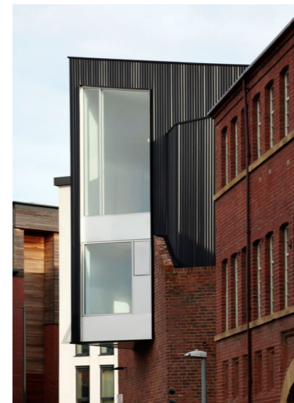
4.01 (à esquerda) Reabilitação de Fachada 1
