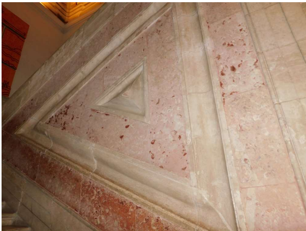
Figura n.º 363 – Teodósio de Frias (1555-1634), alçado do primeiro lanço da escadaria de Mosteiro dos Jerónimos, Lisboa, c. 1625. Fotografia captada pelo autor em 27 de janeiro de 2020.
