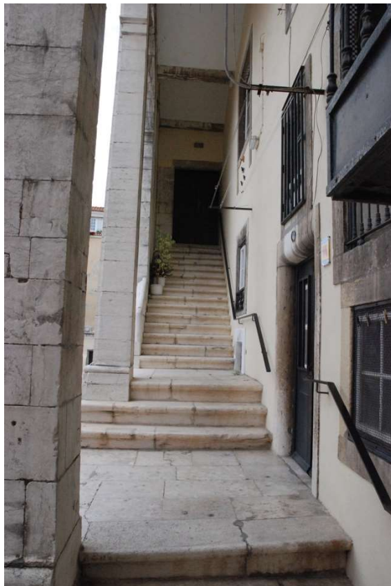
Figura n.º 338 – Afonso Álvares (c. 1500-1580) (atr.), escadaria do Palácio dos Condes de Castanheira, atual Recolhimento de São Cristóvão, Lisboa, c. 1550. Fotografia captada pelo autor em 30 de junho de 2014.
