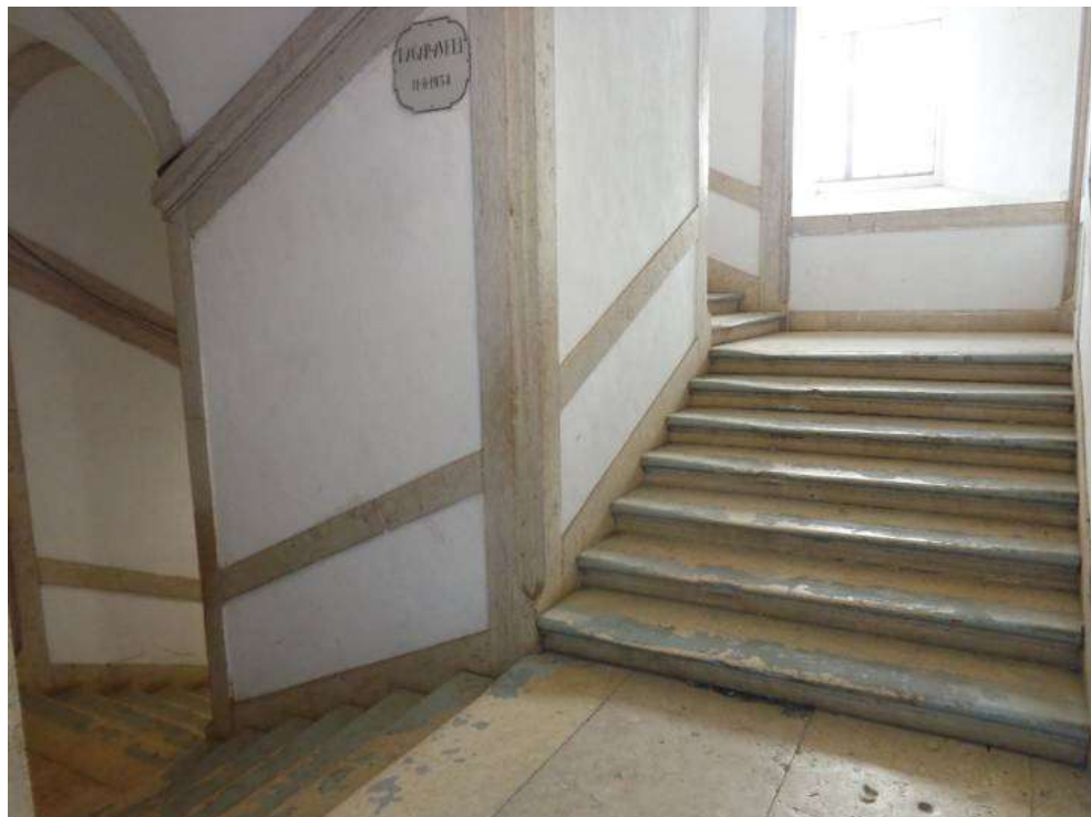
Figura n.º 542 – Escadaria de acesso do edifício nascente à basílica, também denominada de “escadaria da Fonte das Almas”, vista dos lanços entre pisos com janela de iluminação, 1729-1755. Fotografia do autor, captada a 16 de janeiro de 2015.
