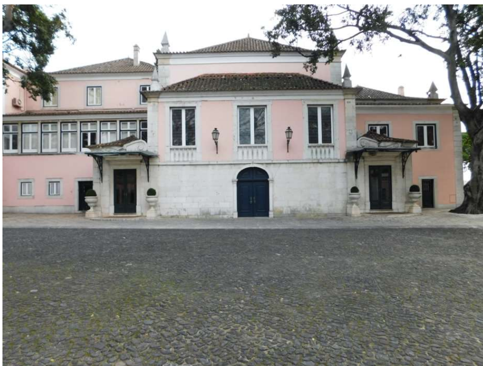
Figura n.º 415 – Fachada lateral do Palácio de Belém, Lisboa, localizada no Pátio dos Bichos, por onde se faz o acesso à escadaria, c. 1720. Fotografia captada pelo autor em 29 de janeiro de 2020.
