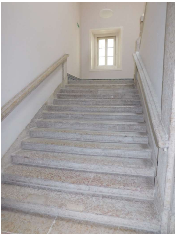
Figura n.º 735 – Quinto lanço da escadaria do Palácio do Principal Portugal da Gama, Lisboa, de acesso aos quartos dos criados, onde os paramentos já não foram revestidos com pintura imitando mármore, 1739-1745. Fotografia captada pelo autor em 23 de junho de 2021.
