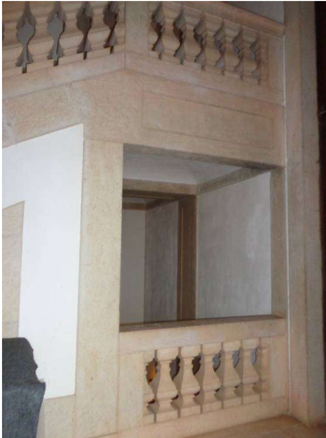
Figura n.º 529 – Antonio Canevari (1681-1764) (atr.), escadaria de acesso privativo aos aposentos reais, ponto de vigia para os lanços inferiores existente na sala utilizada como patamar intermédio com janelas de iluminação, 1729-1755. Fotografia captada pelo autor em 16 de janeiro de 2015.
