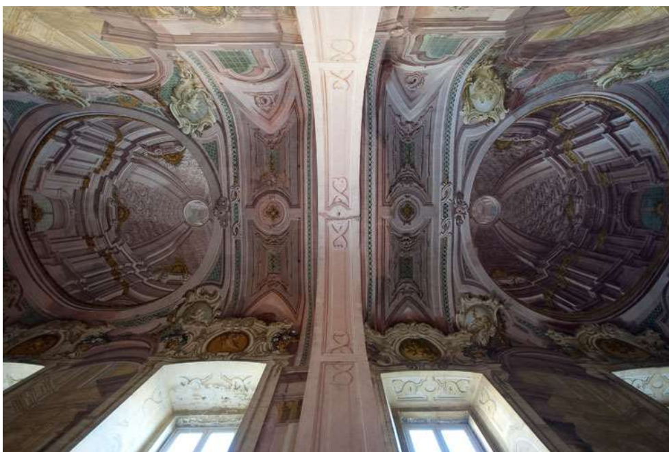
Figura n.º 225 – Antonio Canevari (1681-1764), cobertura de uma das duas escadaria da Reggia de Portici, 1738-1758. Fotografia disponível em: https://www.centromusa.it/real-sito-di-portici.html [consultado em 25 de março de 2019]
