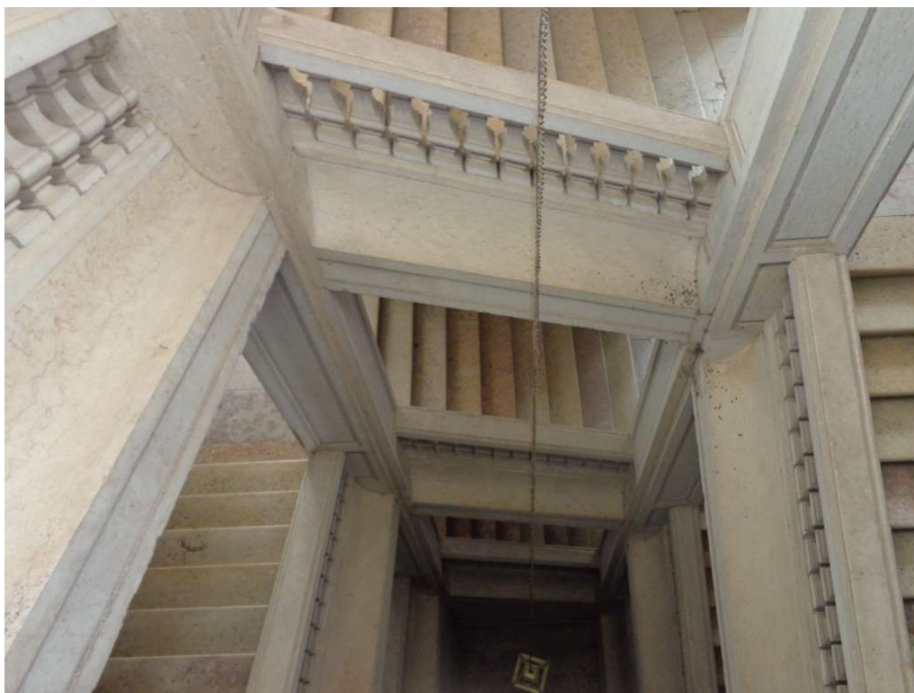
Figura n.º 488 – Antonio Canevari (1681-1764) e Custódio Vieira (1682-1744) (atr.), escadaria dupla do corpo nascente do Real Edifício de Mafra, vista de um saguão, 1729-1755. Fotografia captada pelo autor em 16 de janeiro de 2015.
