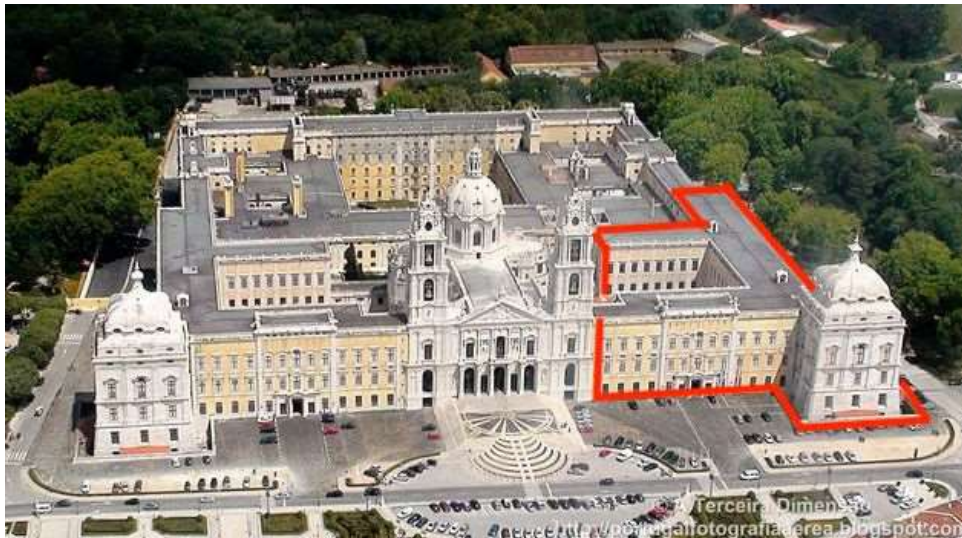
Figura n.º 470 – Real Edifício de Mafra, 1729-1755, fotografia aérea a partir de poente, com a marcação do palácio sul. Fotografia de Terceira Dimensão, publicada em 12 de maio de 2015, disponível em: http://portugalfotografiaaerea.blogspot.com/2015/05/palacio-nacional-de-mafra.html [consultado em 2 de setembro de 2020]
