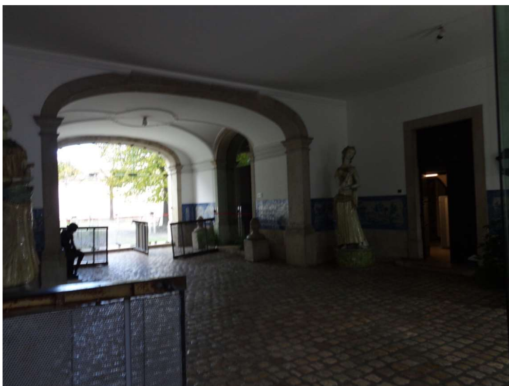
Figura n.º 616 – Átrio coberto do Palácio Pimenta, Lisboa, 1739-1746, o qual faz a articulação entre a via pública e o jardim, possuindo as entradas do palácio nas laterais, permitindo a entrada de coches e da descida dos seus ocupantes junto à entrada da escadaria, a coberto das intempéries. Fotografia captada pelo autor em 3 de novembro de 2014.
