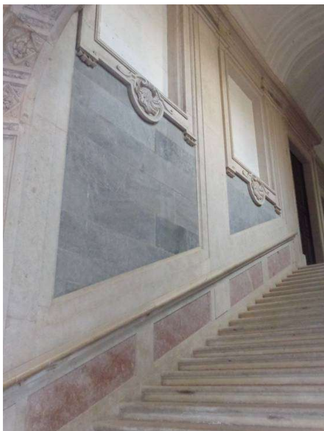
Figura n.º 500 – Filippo Juvarra (1678-1736) e Antonio Canevari (1681-1764) (atr.), escadaria de acesso à sacristia da Basílica de Mafra com início no corredor meridiano, denominado “das aulas”, vista do alçado lateral esquerdo, voltado a sul, 1729-1755. Fotografia captada pelo autor em 16 de janeiro de 2015.
