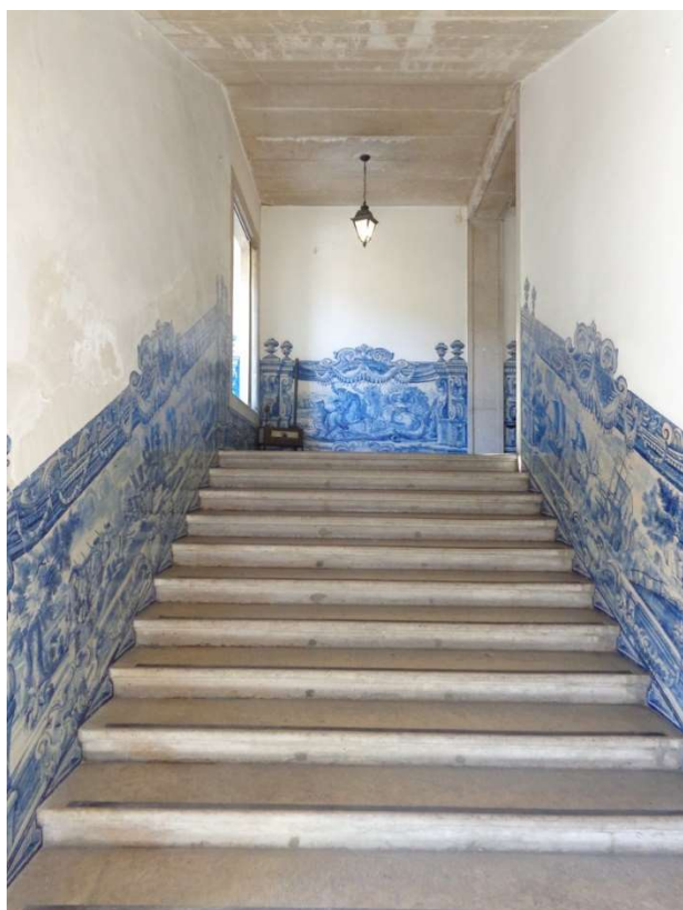
Figura n.º 435 – Custódio Vieira (1682-1744) (atr.), lanço na escadaria de acesso à Aula da Esfera, no Colégio de Santo Antão-o-Novo, Lisboa, 1714-1722. Fotografia captada pelo autor em 12 de novembro de 2014.
