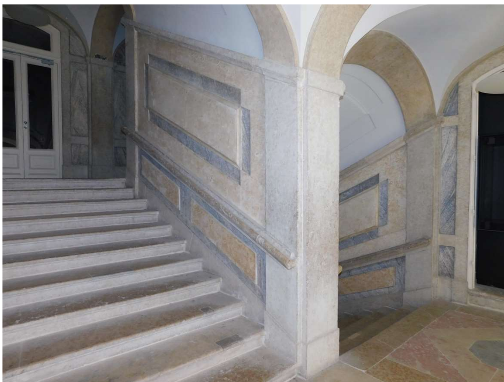
Figura n.º 732 – Ligação do primeiro para o segundo lanço da escadaria do Palácio do Principal Portugal da Gama, Lisboa, sendo que o primeiro patamar abre para um saguão interno que ilumina a escadaria, 1739-1745. Fotografia captada pelo autor em 23 de junho de 2021.
