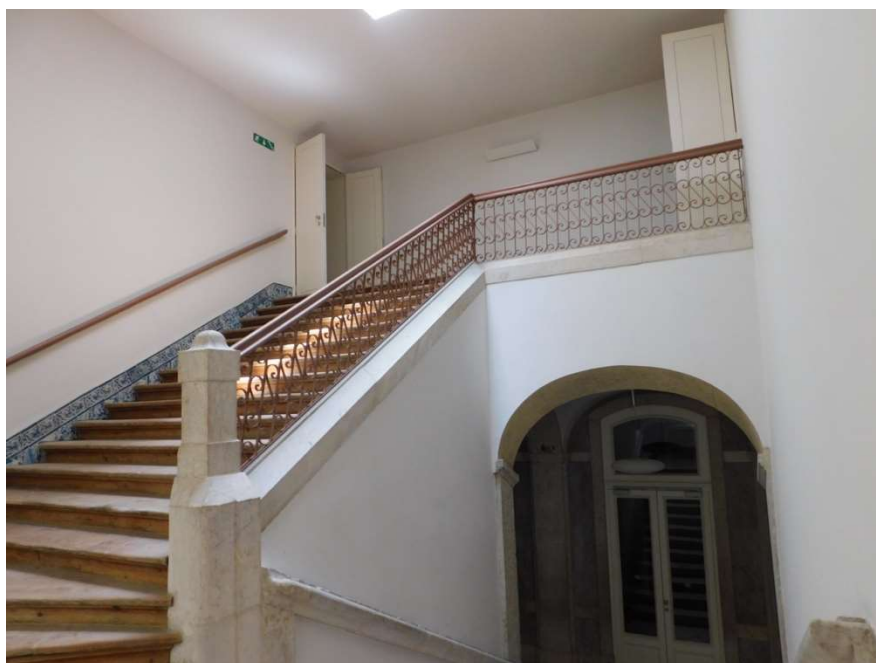
Figura n.º 736 – Sexto e último lanço da escadaria do Palácio do Principal Portugal da Gama, Lisboa, de acesso aos quartos dos criados, 1739-1745, com adições do século XIX. Fotografia captada pelo autor em 23 de junho de 2021.
