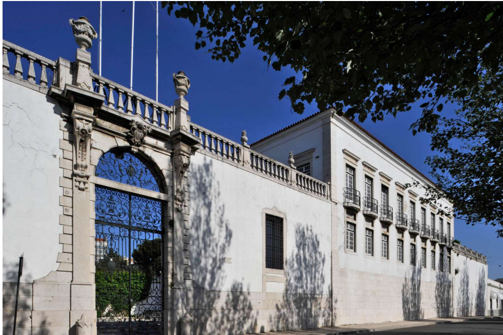
Figura n.º 569 – Antonio Canevari (1681-1764) (atr.), fachada principal do Palácio da Mitra de Marvila, Lisboa, 1727-1744, vista geral. Fotografia disponível em: http://acasasenhorial.org/acs/index.php/en/manor-houses/pesquisa-avancada-en/143-palacio-da-mitra [consultado em 24 de junho de 2021]
