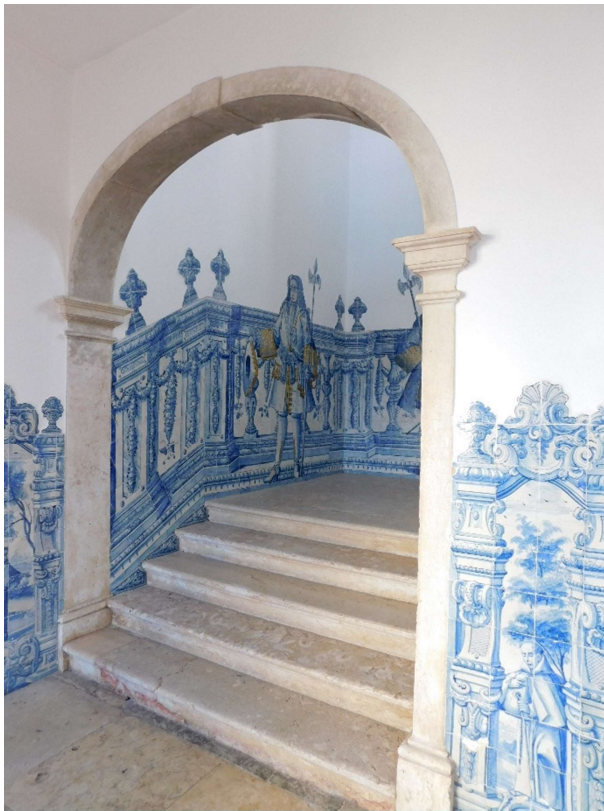
Figura n.º 605 – Antonio Canevari (1681-1764), vão de acesso à escadaria do Palácio da Mitra de Santo Antão do Tojal, Loures, 1731-1750. Fotografia captada pelo autor em 19 de novembro de 2021.
