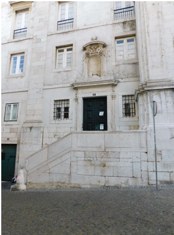
Figura n.º 693 – Portal de acesso ao interior do Hospital Real do Menino Deus, Lisboa, 1738-1751. Fotografia captada pelo autor em 2 de julho de 2021.
