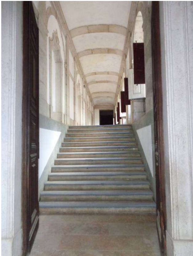
Figura n.º 514 – Filippo Juvarra (1678-1736) e Antonio Canevari (1681-1764) (atr.), escadaria de acesso às tribunas laterais da capela do Campo Santo e à enfermaria conventual partindo do corredor meridiano denominado “das aulas”, 1729-1755, lanço de escada de acesso ao corredor que acede à tribuna norte da capela do Campo Santo e à antiga capela real (enfermaria). Fotografia captada pelo autor em 16 de janeiro de 2015.
