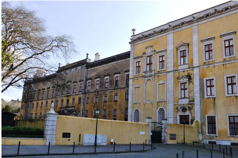
Figura n.º 457 – Alçado lateral voltado a norte do Real Edifício de Mafra, 1729-1755, onde se verifica a cópia do remate lateral da casa professa dos oratorianos de Roma. Fotografia publicada em 9 e janeiro de 2013, disponível em: http://parquedospoetas.blogspot.com/2013/01/mafra-mais-um-quartel.html [consultado em 2 de outubro de 2017].
