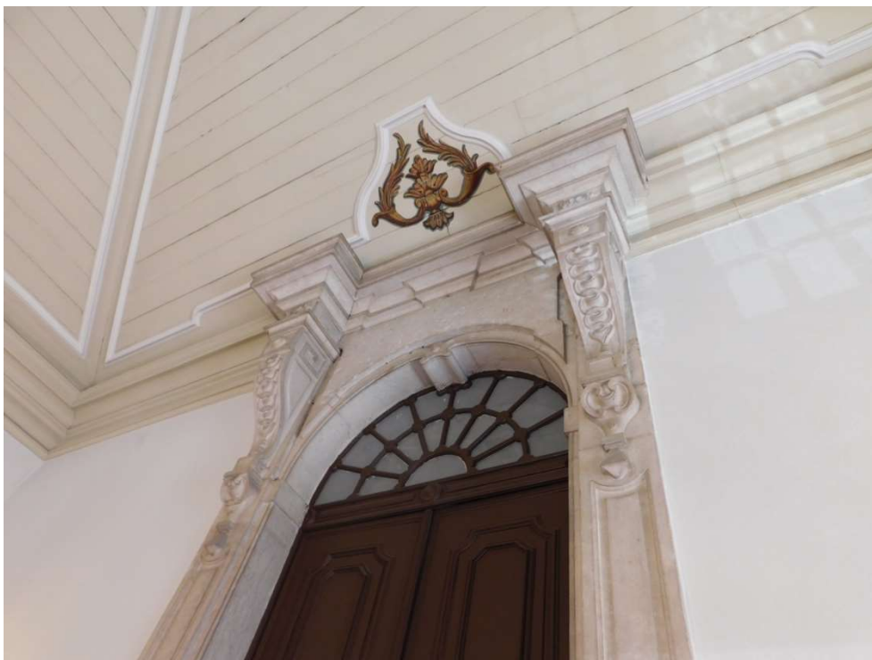
Figura n.º 595 – Antonio Canevari (1681-1764) e Custódio Vieira (1682-1744) (atr.), portal de acesso aos salões nobres do Palácio da Mitra de Marvila, colocado no final da escadaria, Lisboa, 1727-1744. Fotografia captada pelo autor em 8 de julho de 2021.
