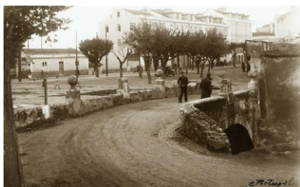
FIGURA 09 Ponte sobre a Ribeira com a rua Major Afonso Palla em segundo plano.
