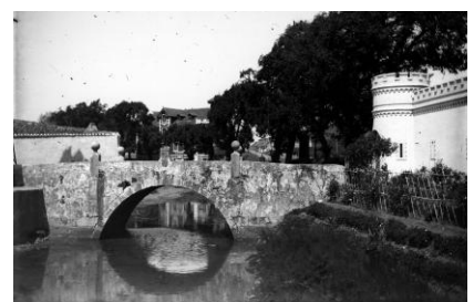
FIGURA 08 Imagem da antiga ponte sobre a ribeira de Algés, e o muro da entrada fiscal de Lisboa.
