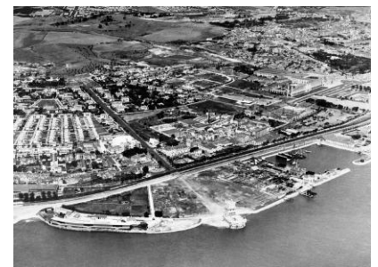
FIGURA 18 19 Fotografias da demolição da fábrica de gás em Belém
