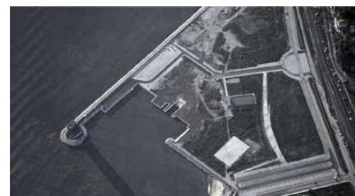
FIGURA 26 Fotografia aérea do Terraplino de Algés.
