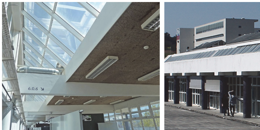
Figura 92 a) Claraboia, e iluminação artificial das salas. b) Exterior das salas e estores.
