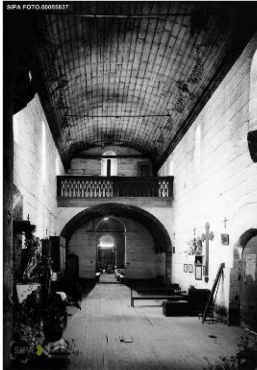
Fig. 59 Nave ainda com os rebocos © IHRU: DGEMN/DSID IPA.00001921
