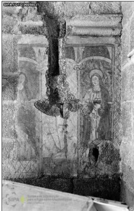
Fig. 72 Pinturas murais existentes na igreja © IHRU: DGEMN/DSID IPA.00001084
