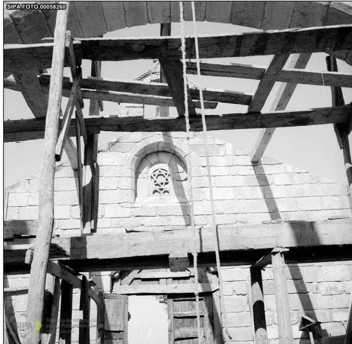
Fig. 90 Intervenção na fachada © IHRU: DGEMN/DSID IPA.00002120
