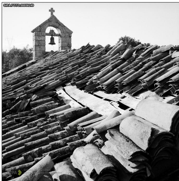
Fig. 88 Reconstrução do telhado © IHRU: DGEMN/DSID IPA.00002120
