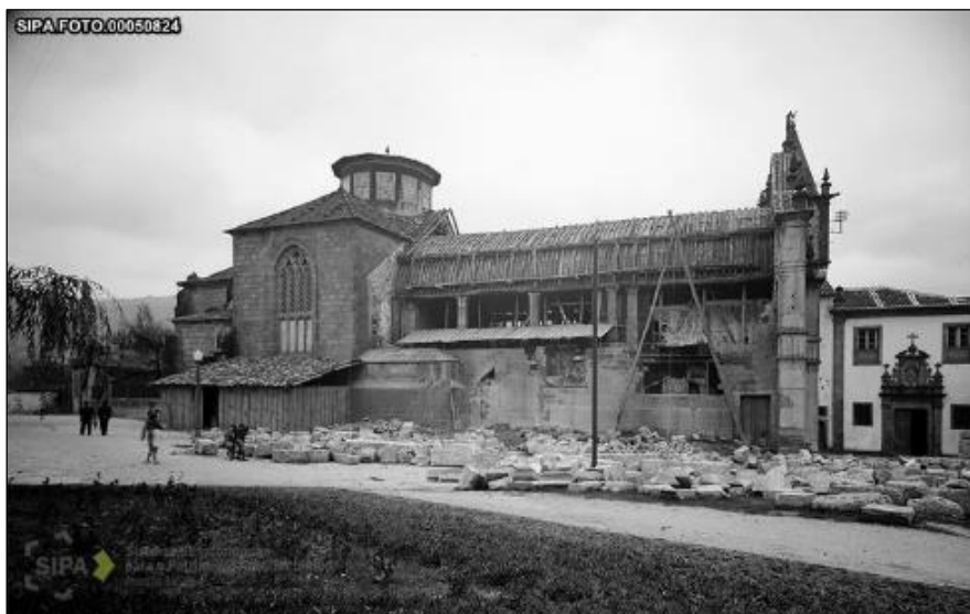
Fig. 41 Vista geral das obras © IHRU: DGEMN/DSID IPA.00000305
