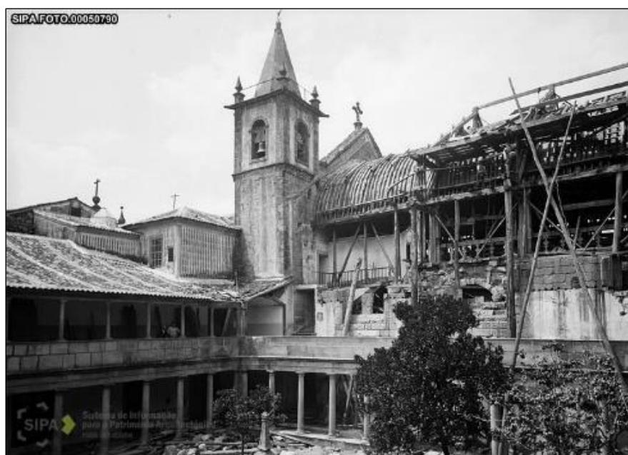
Fig. 42 Conjunto de fachadas do claustro e torre sineira em obras © IHRU: DGEMN/DSID IPA.00000305
