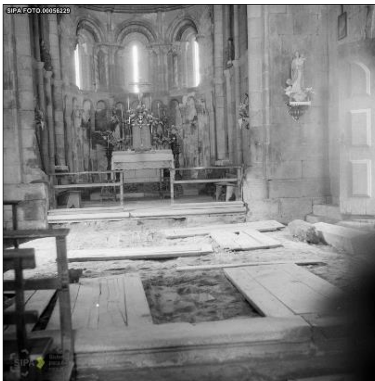
Fig. 39 Obras ao nível do pavimento © IHRU: DGEMN/DSID IPA.00000287
