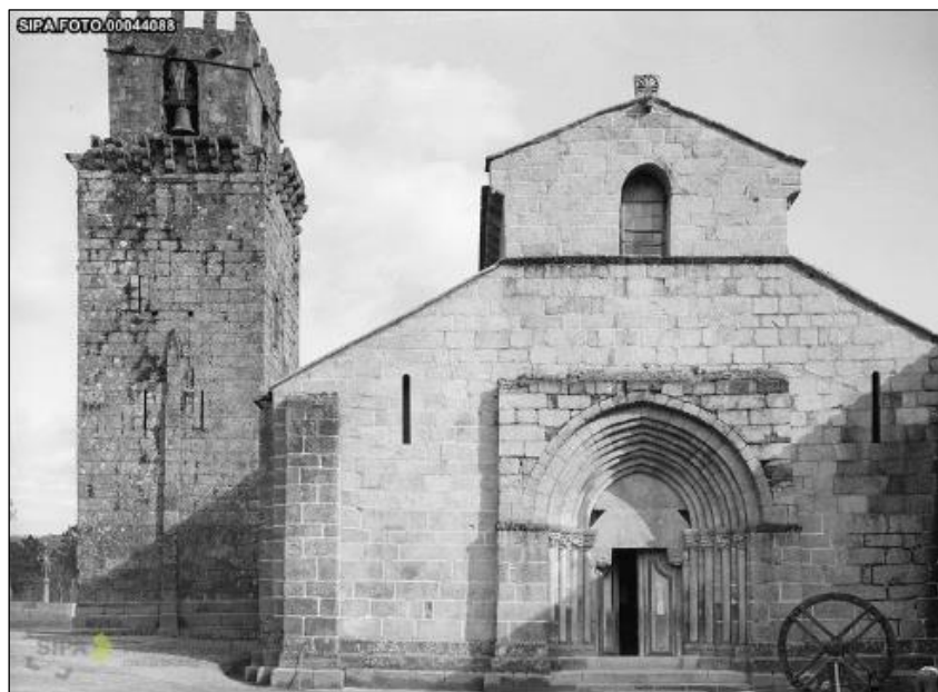
Fig. 61 Fachada principal © IHRU: DGEMN/DSID IPA.00003954
