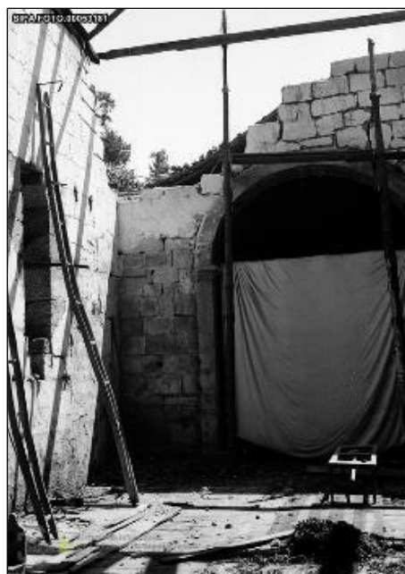
Fig. 67 Interior em ruína
