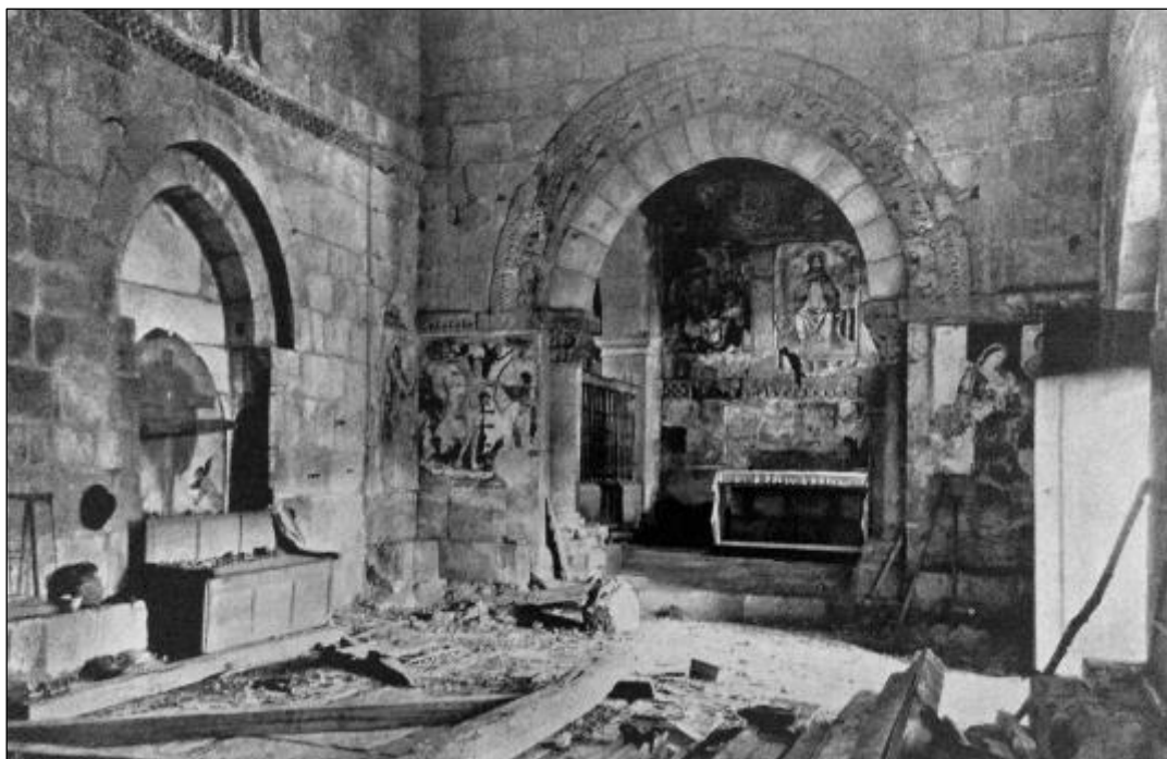
Fig. 21 Interior da igreja durante as obras. © IHRU: DGEMN/DSID IPA.00002175
