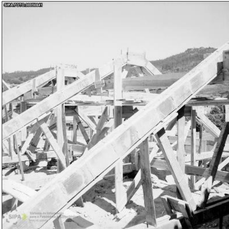
Fig. 43 Reparações da cobertura a 1966 © IHRU: DGEMN/DSID IPA.00000305
