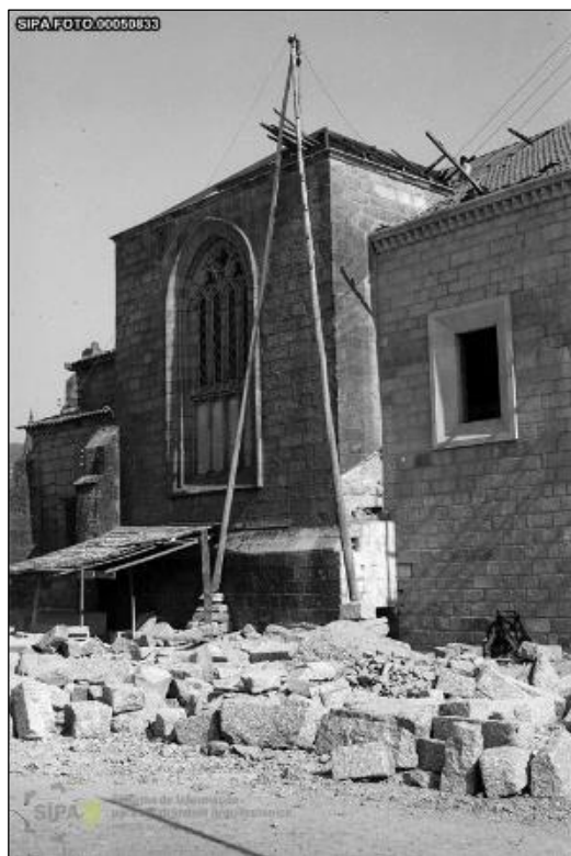
Fig. 44 Fachada lateral esquerda e transepto durante as obras © IHRU: DGEMN/DSID IPA.00000305
