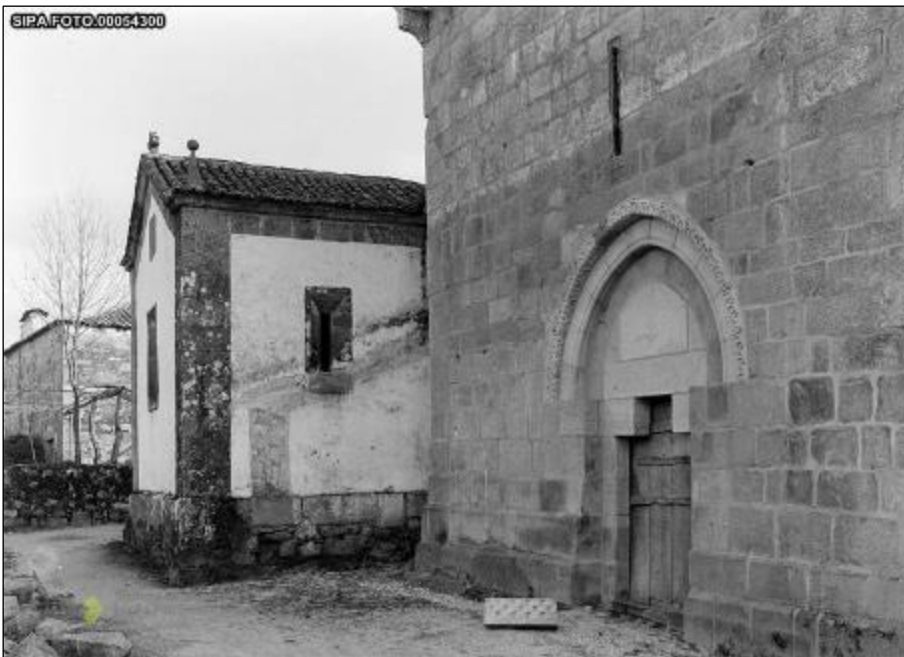
Fig. 18 Capela particular adossada à igreja (2). © IHRU: DGEMN/DSID IPA.00002175
