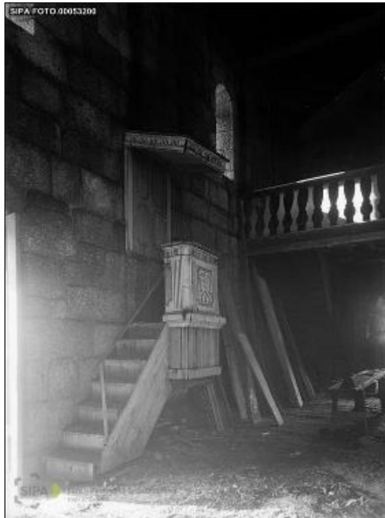
Fig. 68 Porta emparedada © IHRU: DGEMN/DSID IPA.00004827
