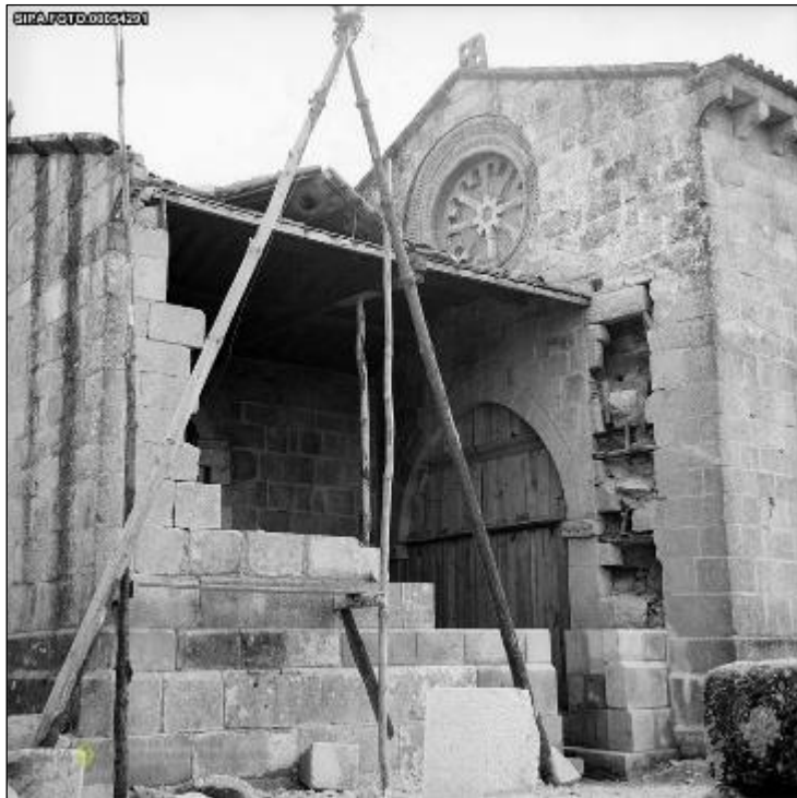
Fig. 19 Exterior durante as obras. © IHRU: DGEMN/DSID IPA.00002175
