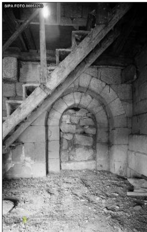
Fig. 69 Interior © IHRU: DGEMN/DSID IPA.00004827
