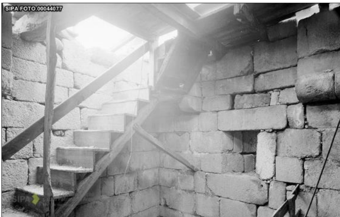
Fig. 64 Escadas e interior © IHRU: DGEMN/DSID IPA.00003954
