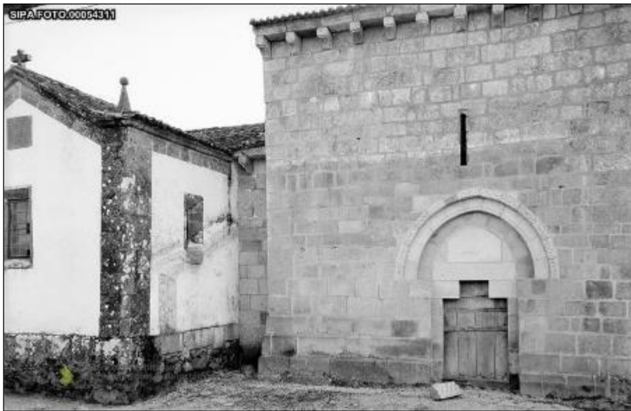
Fig. 17 Capela particular adossada à igreja (1). © IHRU: DGEMN/DSID IPA.00002175
