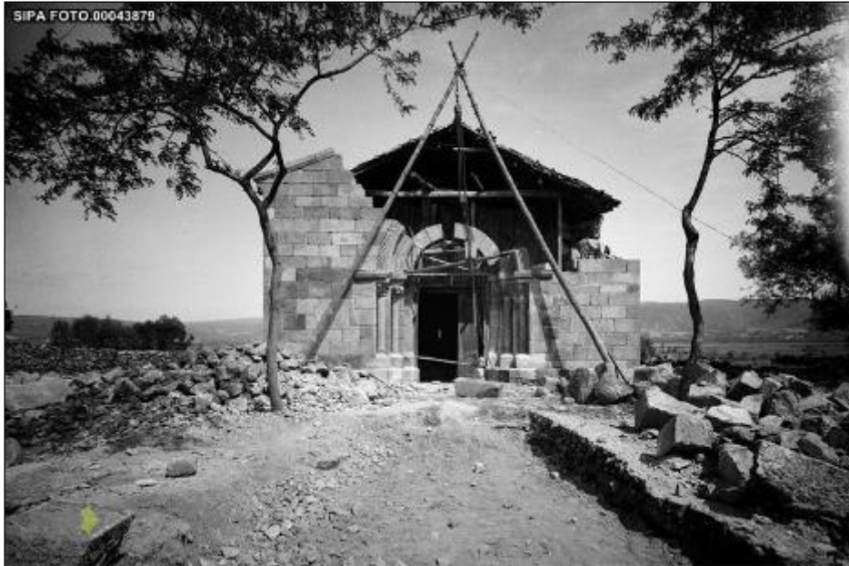
Fig. 80 Intervenção na fachada e telhado © IHRU: DGEMN/DSID IPA.00005780
