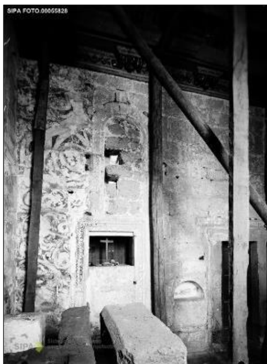
Fig. 49 Vestígios de pintura em 1947 © IHRU: DGEMN/DSID IPA.00001921
