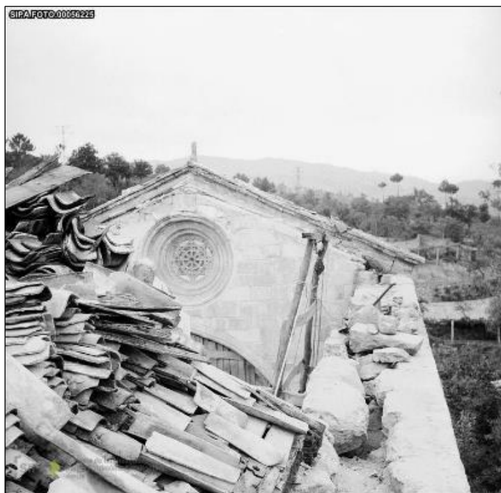
Fig. 37 Obras na cobertura © IHRU: DGEMN/DSID IPA.00000287
