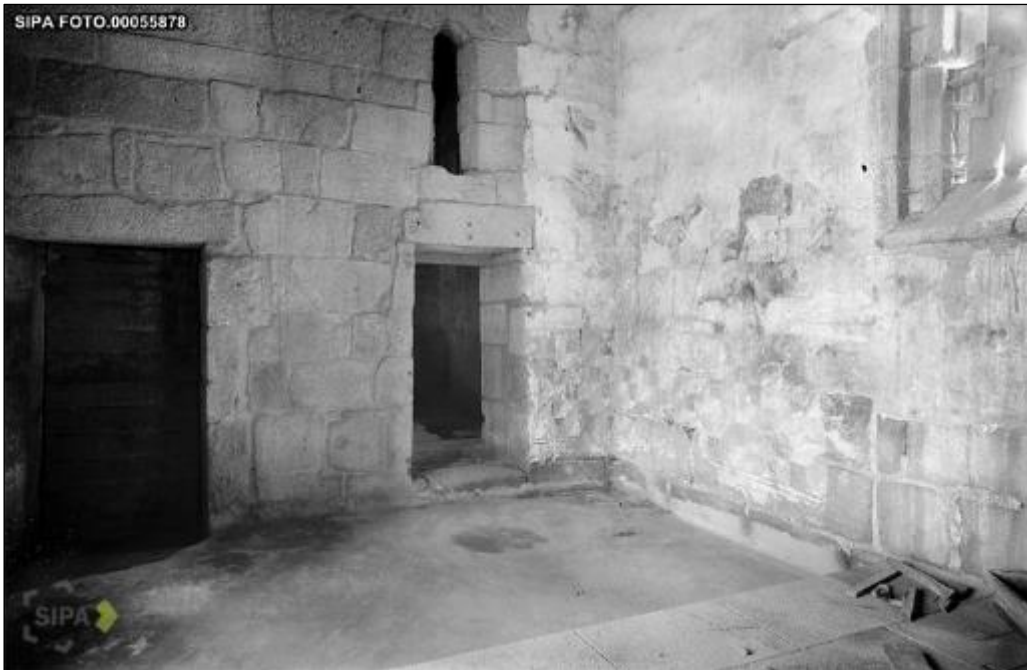
Fig. 51 Vestígios de pintura em 1952 © IHRU: DGEMN/DSID IPA.00001921
