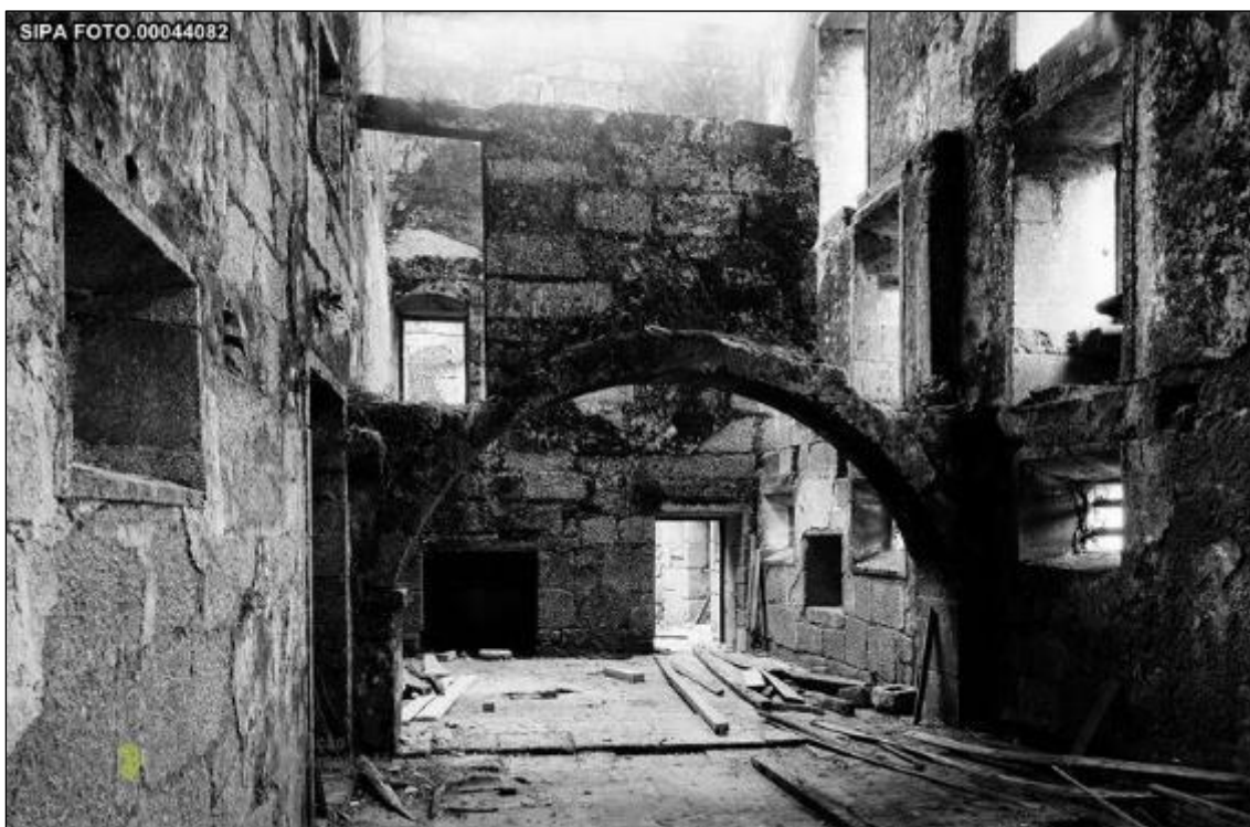
Fig. 63 Interior em ruínas © IHRU: DGEMN/DSID IPA.00003954
