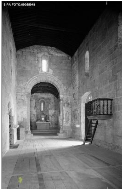
Fig. 60 Nave após picagem dos rebocos © IHRU: DGEMN/DSID IPA.00001921
