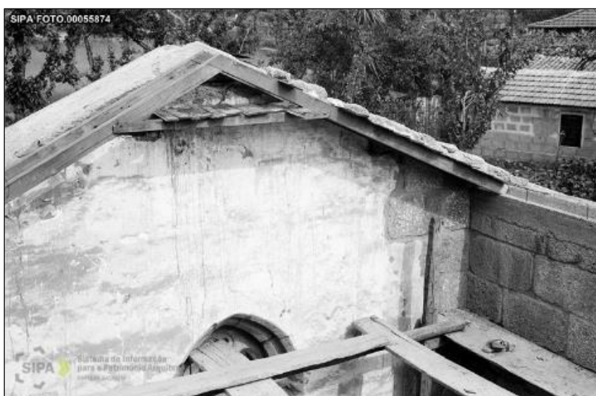
Fig. 56 Obras na cobertura © IHRU: DGEMN/DSID IPA.00001921
