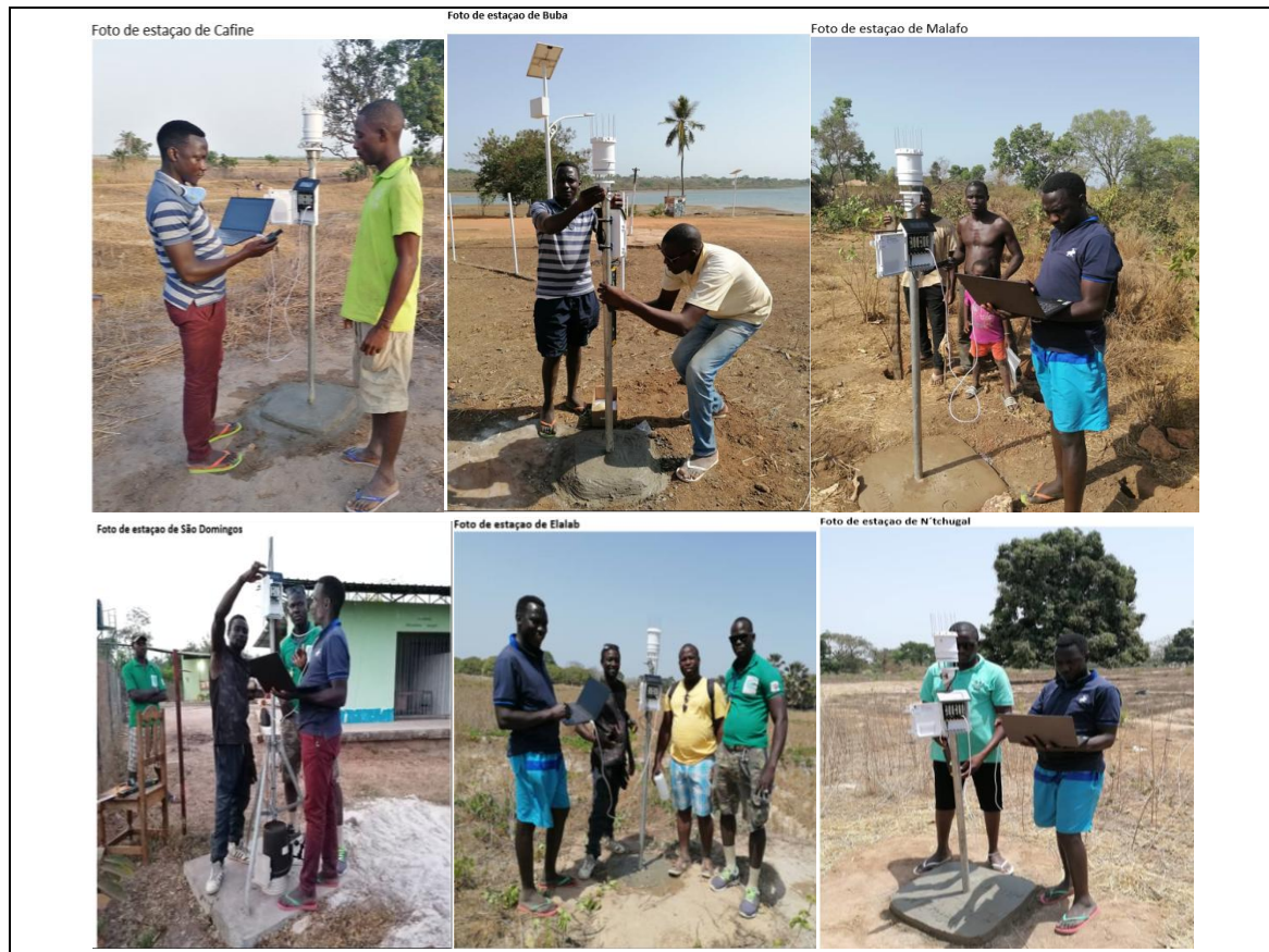
Figura 21. Instalação de algumas das estações meteorológicas ATMOS 41 nas localidades da área de estudo.
