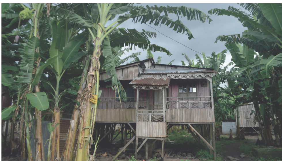
Fig. 26 Uma habitação tradicional vernacular local - construção em amdeira sobre plafitas e com adornos na fachada representativo de uma melhor condição social.
