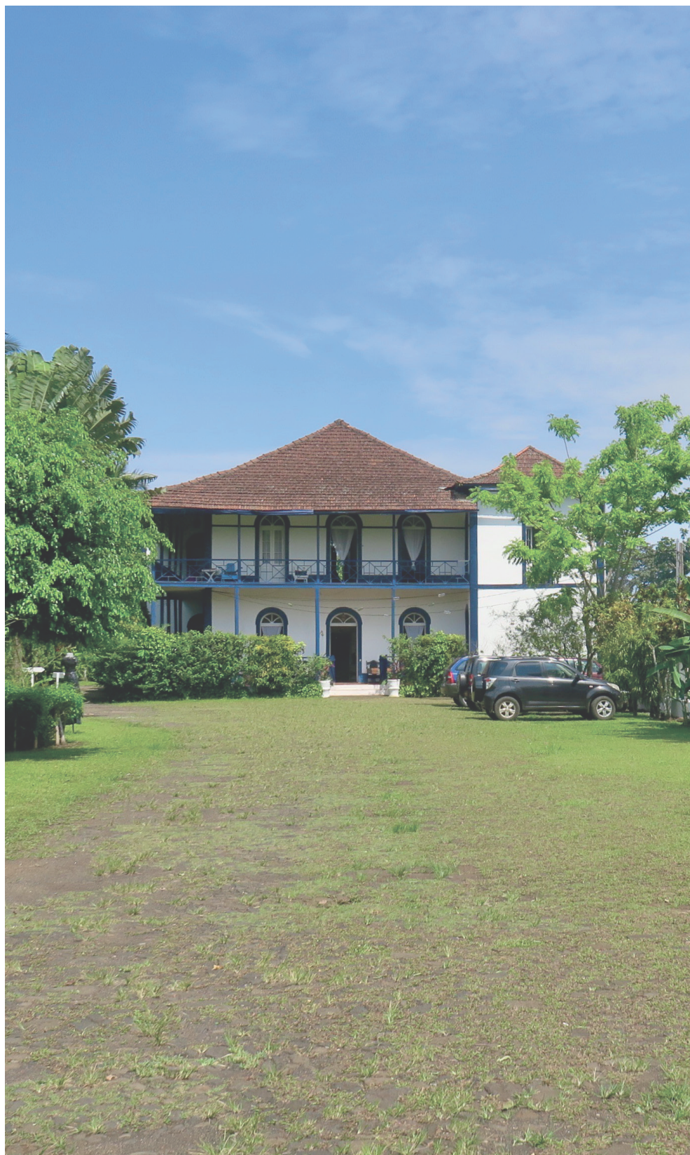
Fig. 40 Alojamento Turístico na Roça São João dos Angolares - Reabilitação da antiga casa principal da roça.
