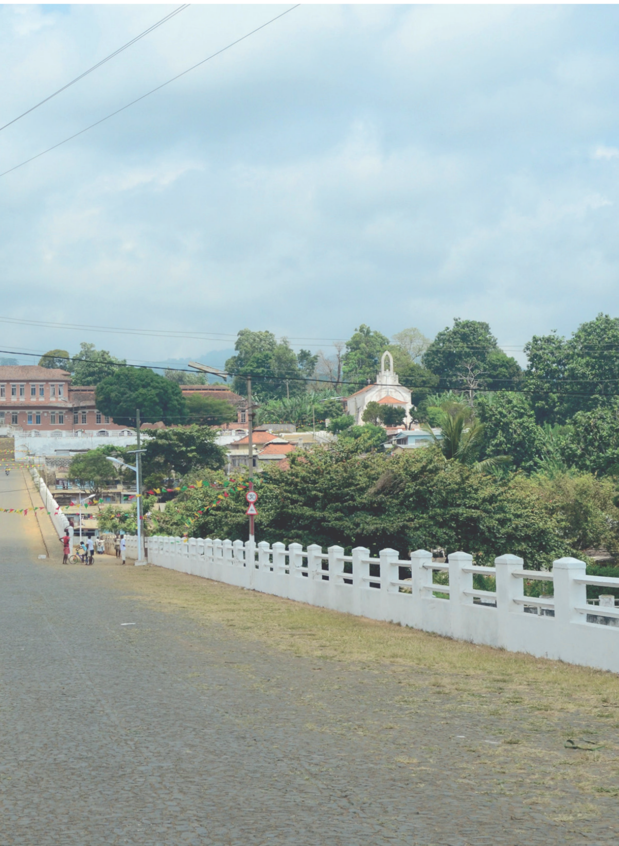
Fig. 46 Roça Rio do Ouro - Vista da Avenida Principal
