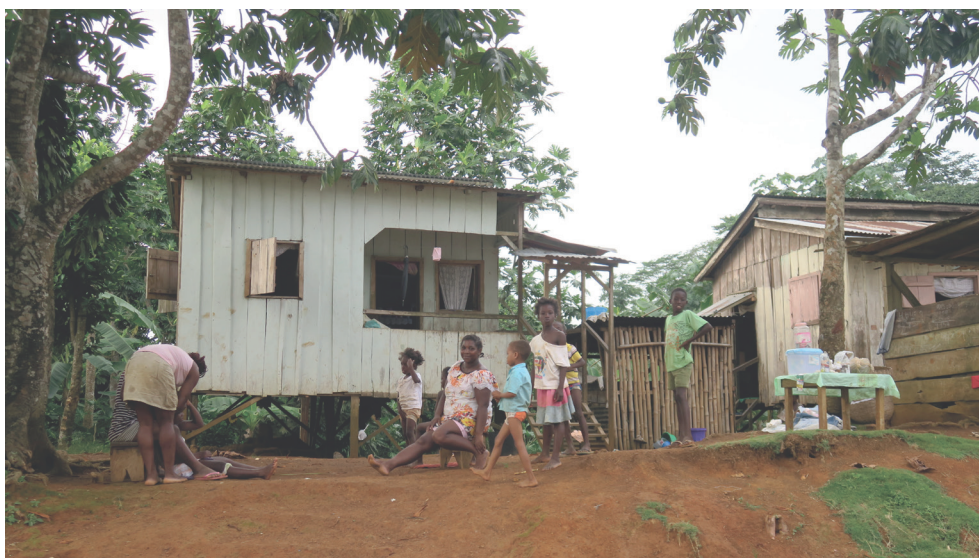
Fig. 24 Arquitectura popular da ilha do Príncipe - construção em madeira sobre palafitas.
