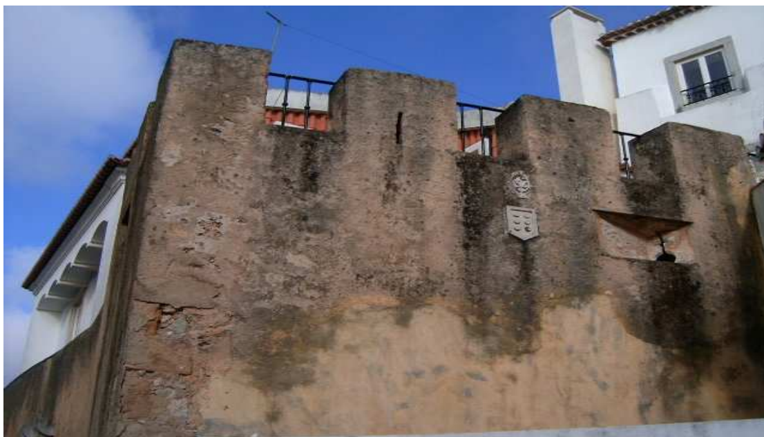
Fig. 20 – Torre-porta que resta das muralhas do castelo medieval de Cascais. Ao centro o brasão dos Castro sobreposto por uma esfera armilar. À direita um tron ou troneira (foto do autor).
