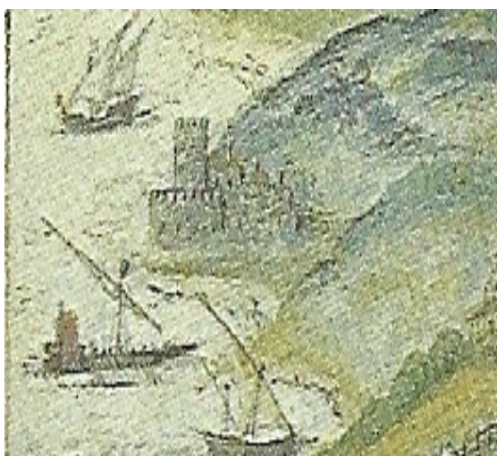
Fig. 31 – Torre de Cascais na Genealogia [...].
