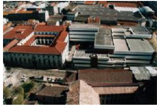
Photo n°50 (détail): L'Ecole EPP, partie gauche ancienne, le cloître, ( la partie droite, moderne, est postérieure dans les années 1990 alors que l'espace devenait le siège de l'ESP.)
