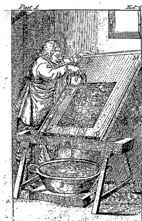
Modo de lançar a gota sobre o tipo.
