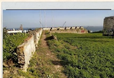
Forte visto de cima
