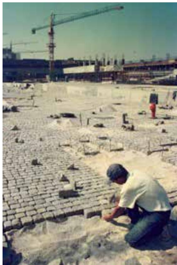
Fig. 16 - Calçada portuguesa na Expo'98, projeto de Xana, em fase de construção com o implemento do granito, antes da aplicação dos calcários, 1997. (Foto: EM)
