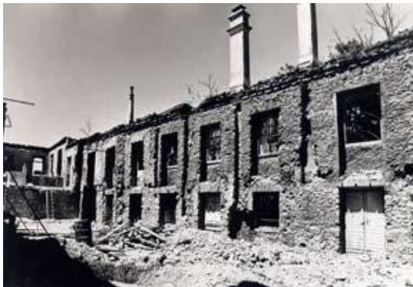
Figura 3 - Palácio Monteiro - Mor, após o incêndio
