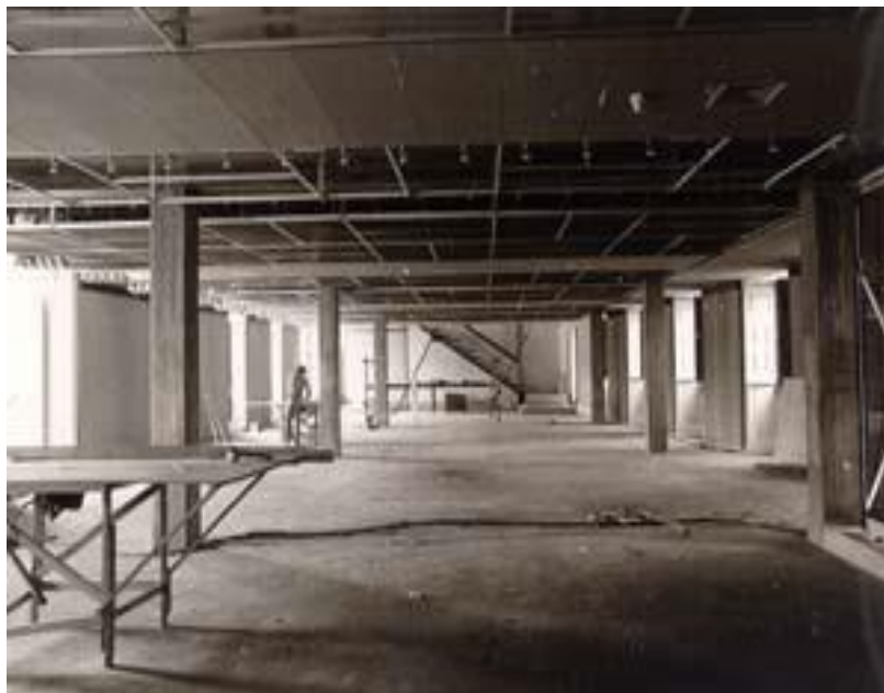
Figura 5 - Início da reabilitação do edifício do Museu Nacional do Teatro e da Dança.
