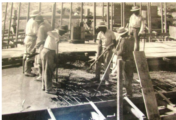
Fotografia 34 — Trabalhadores na construção do Ginásio Notre Dane, 1961.
