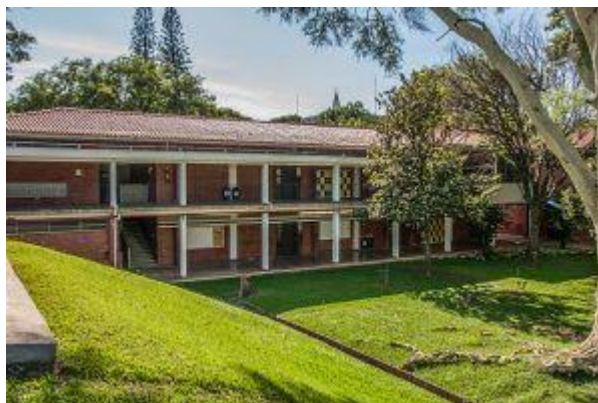
Fotografia 47 — Edifício do Ensino Fundamental II e Ensino Médio, 2017.
